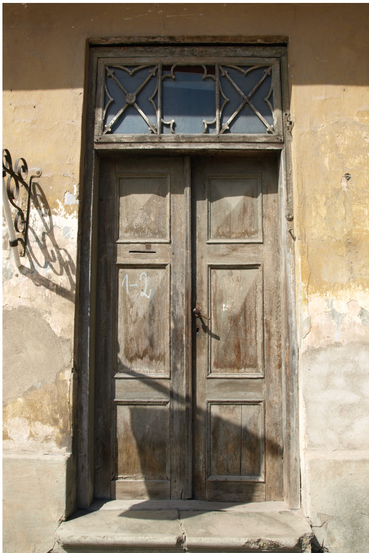
Mucenieku_1_62010230050001_002 _durvis1 Sākotnējs (19.gs.3.cet.) durvju komplekts ar oriģinālo aprīkojumu.
