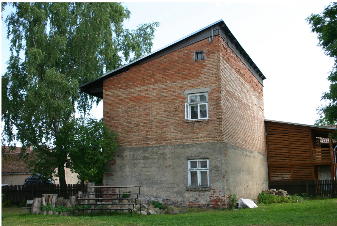
Liepaajas_8_62010230035003_fasade2 Skats uz ēku no ziemeļrietumiem.
