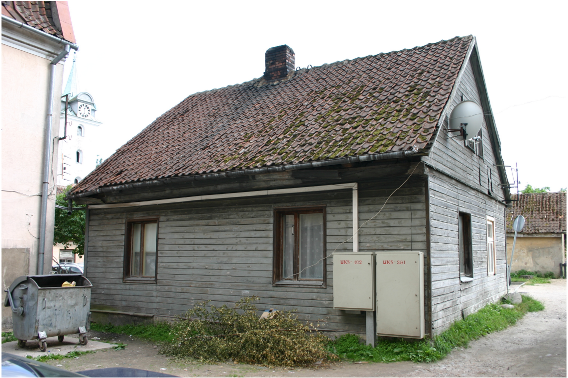
Liepaajas_8_62010230035002_fasade3 Skats uz ēku no ziemeļrietumiem.
