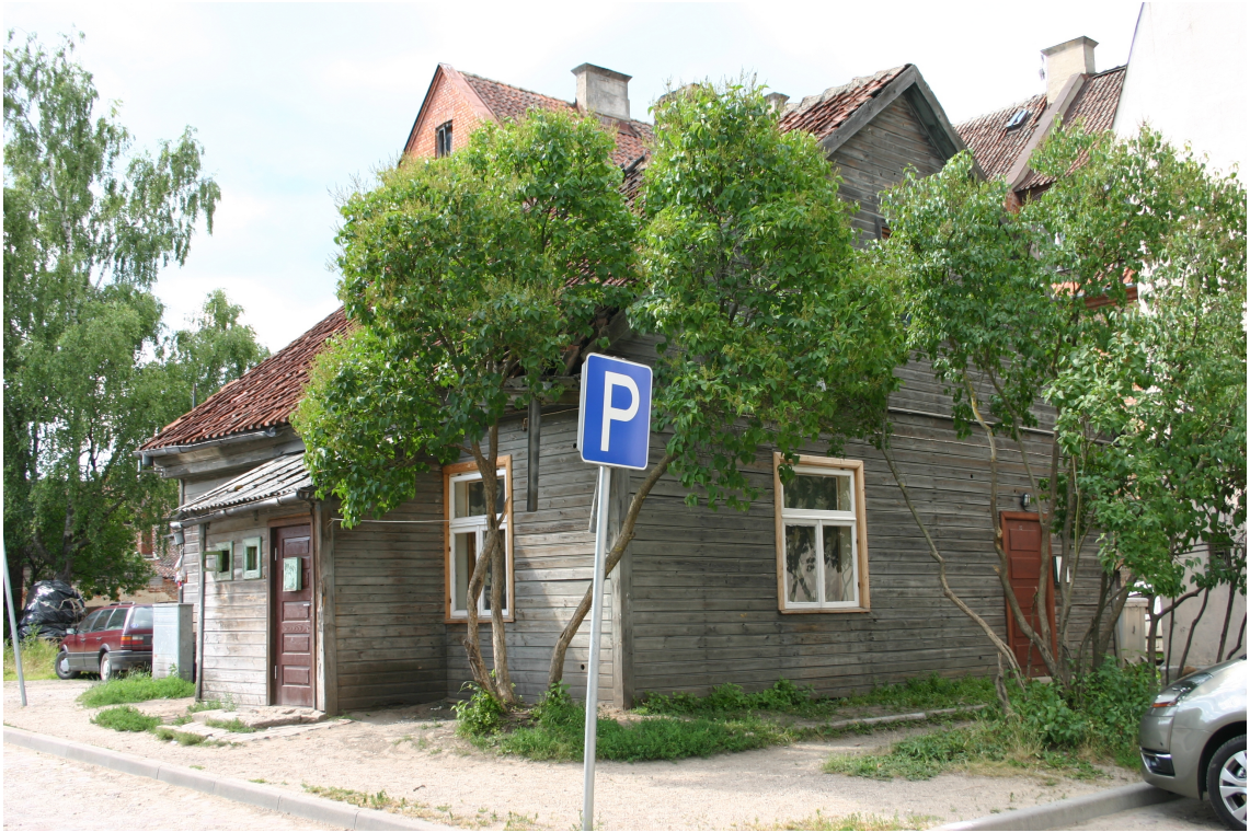
Liepājas_8_62010230035002_fasade1 Skats uz ēku no dienvidaustrumiem.
