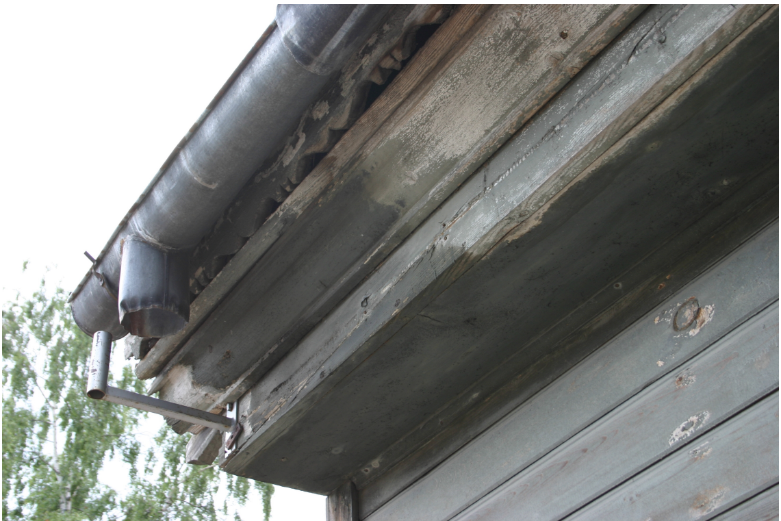
Liepaajas_8_62010230035002_dzega1 Sākotnēja (19.gs.3.cet.) dēļu dzega un kokā griezts aizsegdēlis.
