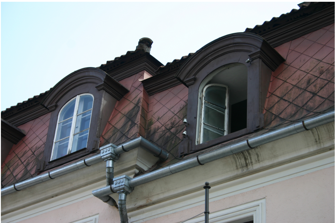
Liepājas_8_62010230035001_fragments1 Sākotnējās (1913.g.) jumta izbūves ar oriģinālajiem logiem. Sākotnējs skārda segums.
