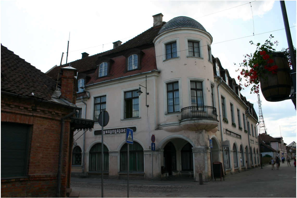
Liepājas_8_62010230035001_fasade1 Skats uz ēku no ziemeļaustrumiem.
