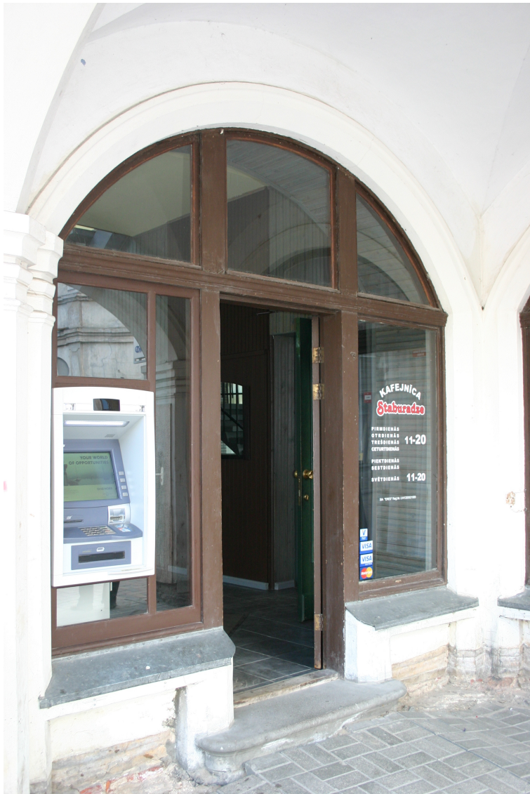
Liepaajas_8_62010230035001_logs2 Sākotnējs (1913.g.) skatlogs ar durvīm. Durvju vērtne un loga apakšējās vērtnes – 20.gs.2.puse. Augšējām vērtnēm zuduši spraišļi.
