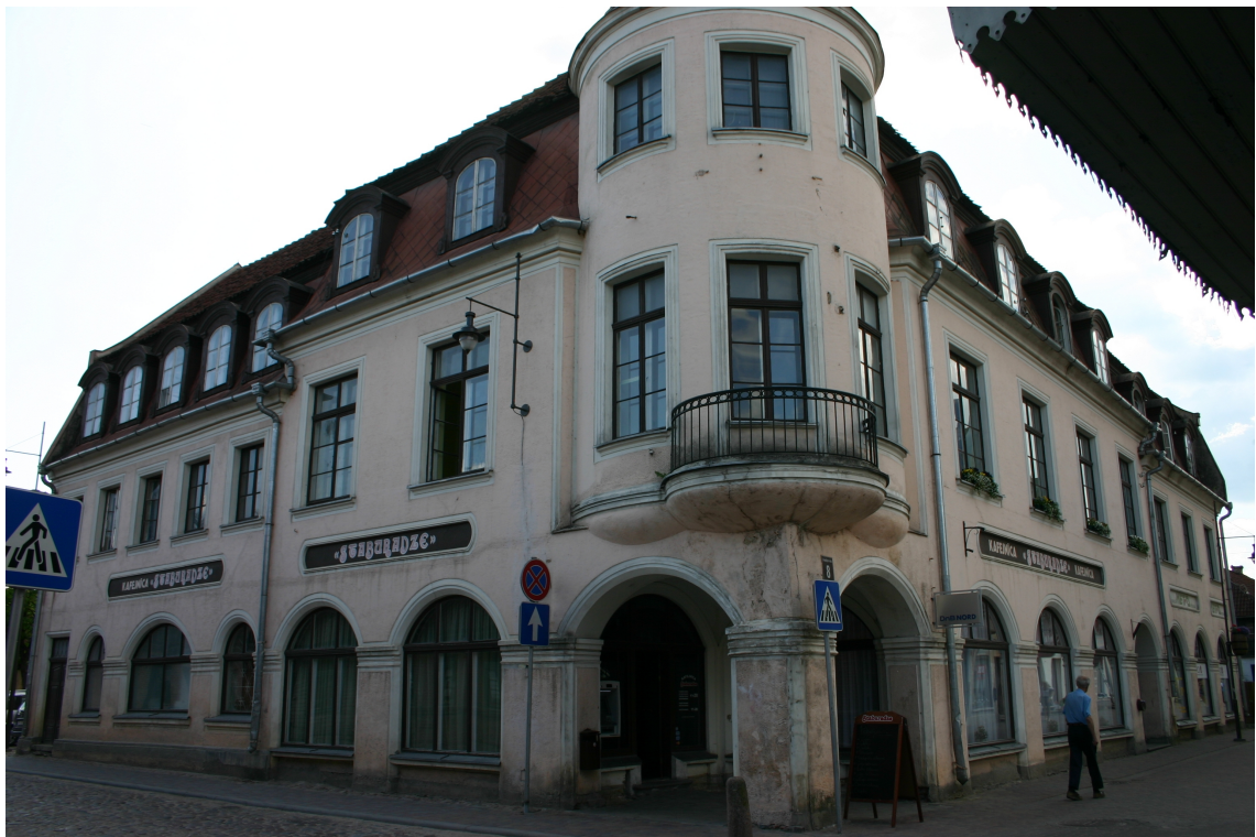
Liepājas_8_62010230035001_fasade2 Skats uz ēku no ziemeļaustrumiem.
