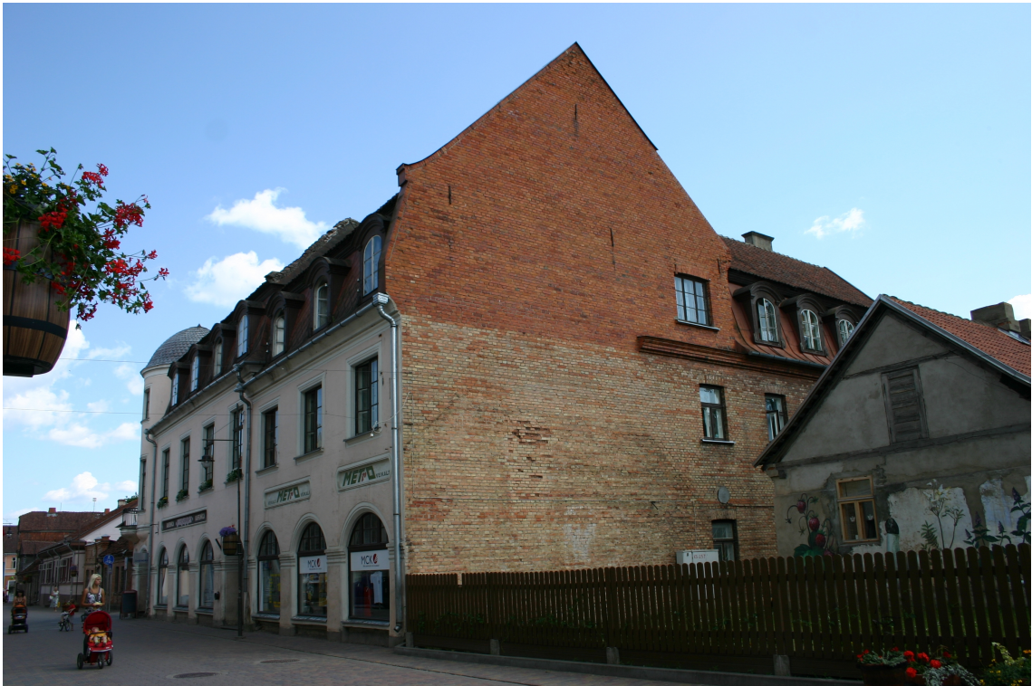
Liepājas_8_62010230035001_fasade4 Skats uz ēku no ziemeļrietumiem.
