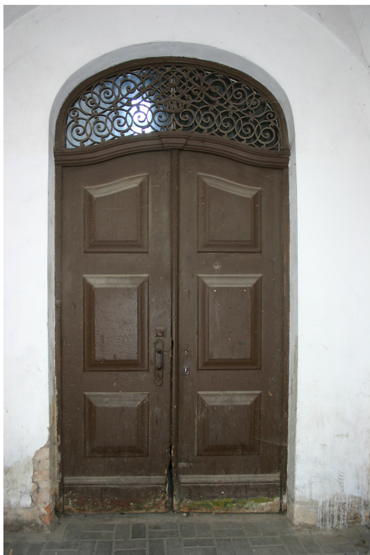
Liepaažas_8_62010230035001_durvis1 Sākotņējs (1913.g.) durvju komplekts un metālkaluma reste.
