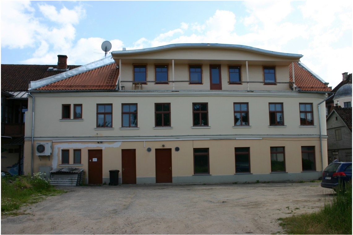
Liepaajas_7_62010060003001_fasade3 Ēkas ziemeļu fasāde. Jumta izbūve – 20.gs.2.puse.
