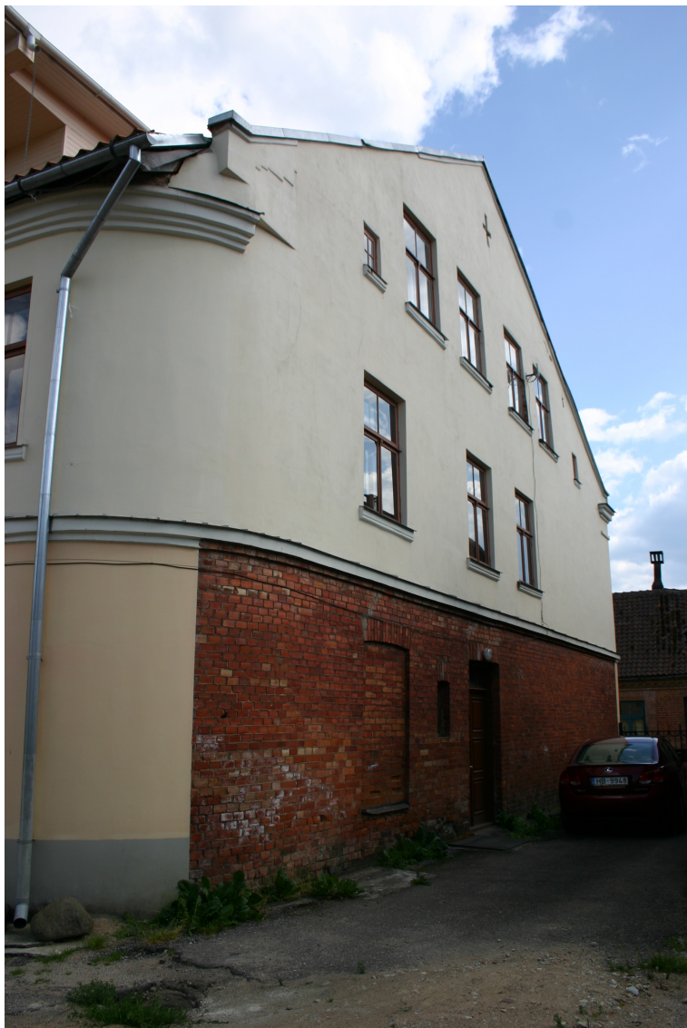
Liepājas_7_62010060003001_fasade2 Ēkas rietumu fasāde.
