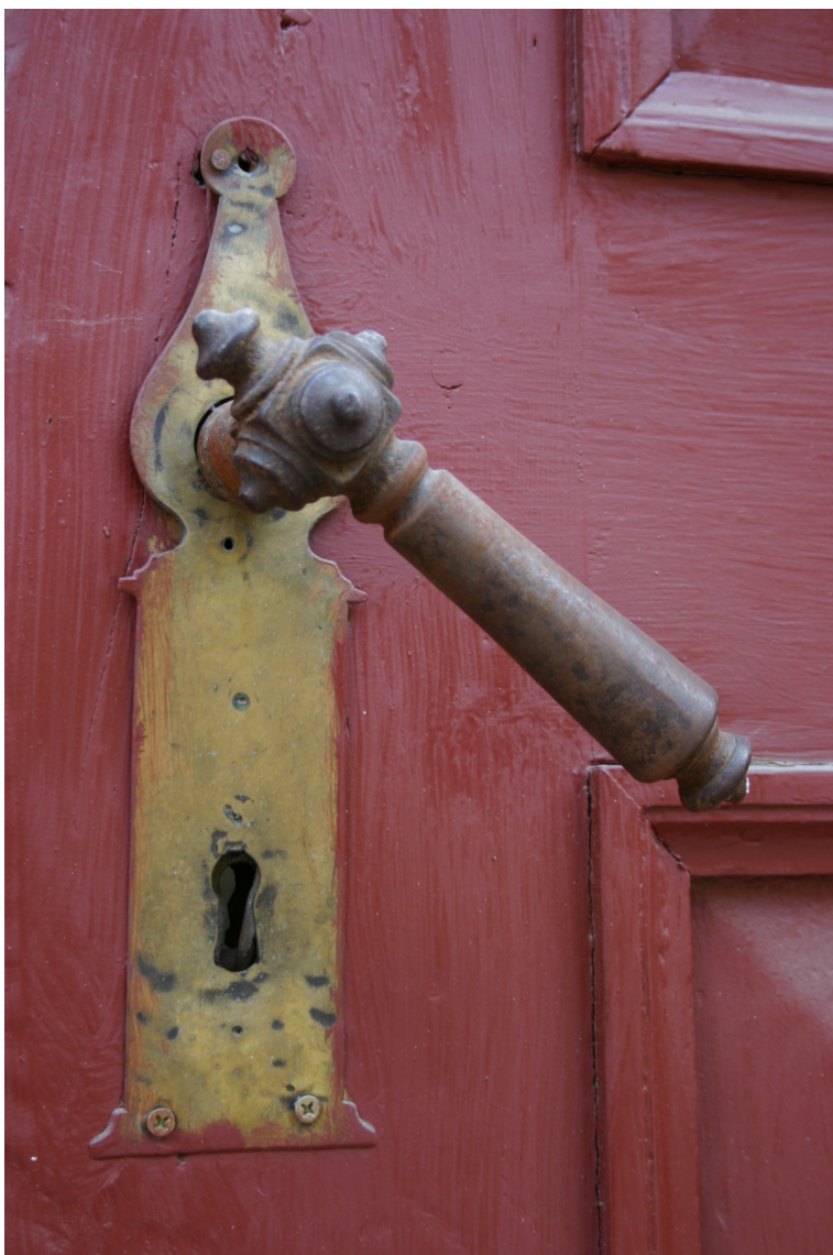
Liepaajas_6_62010230002004_durvis2 Sākotnējs (19.gs.vidus) durvju aprīkojums.
