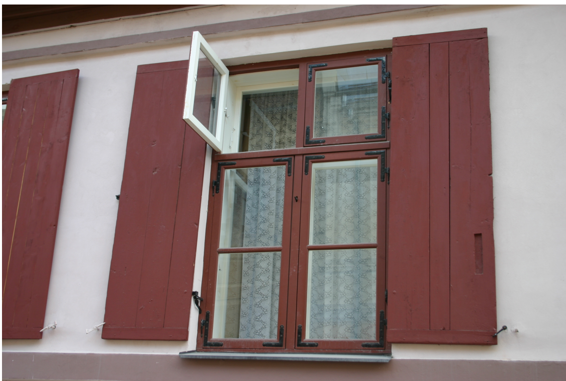
Liepaajas_6_62010230002004_slegi1 Sākotnēji (19.gs.vidus) slēgi ar aprīkojumu. 2007.g. logs, kam izmantots sākotnējais (19.gs.v.) aprīkojums.
