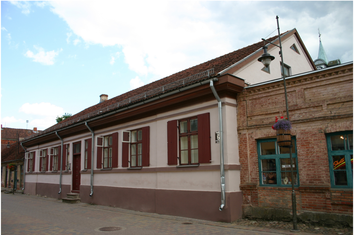
Liepaajas_6_62010230002004_fasade1 Skats uz ēku no ziemeļrietumiem.
