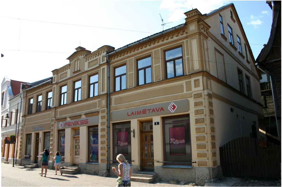
Liepājas_5_62010060034001_fasade1 Skats uz ēku no dienvidaustrumiem.
