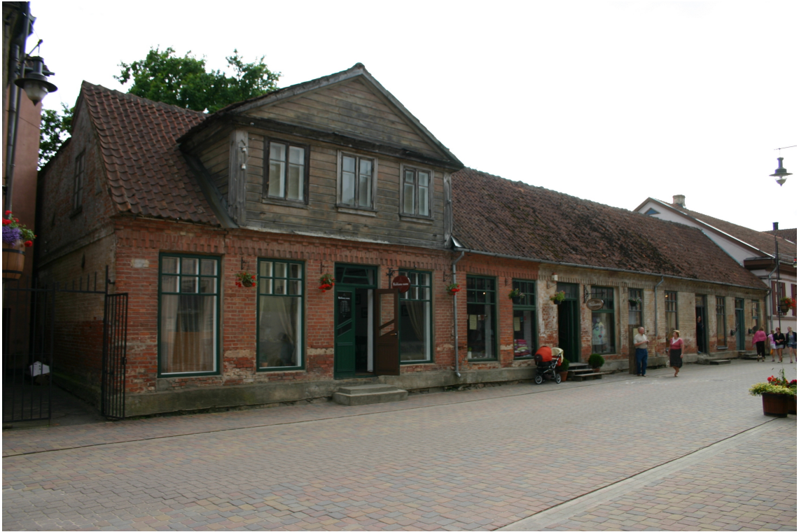
Liepājas_4_62010230002001_fasade1 Skats uz ēku no ziemeļaustrumiem.
