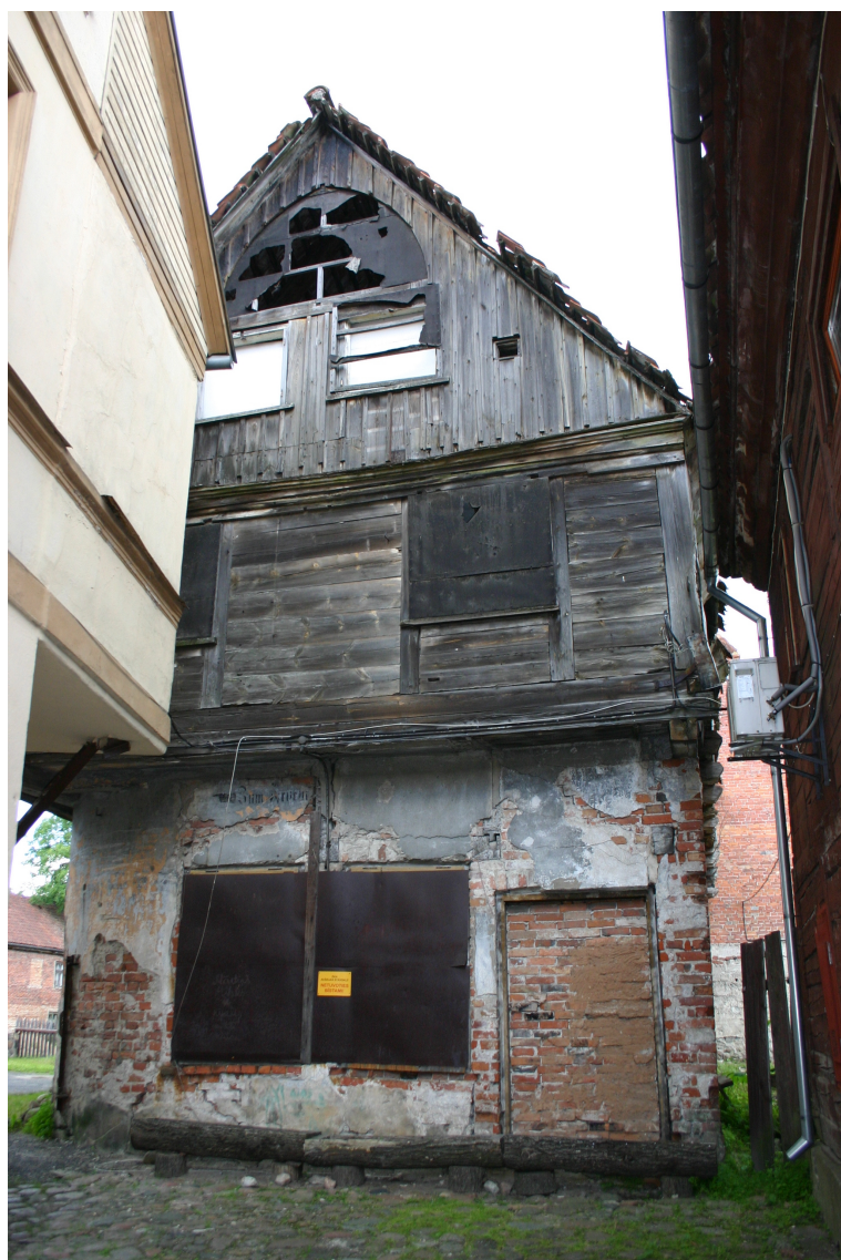
Liepājas_3a_62010060084001_fasade2 Ēkas dienvidu fasāde.
