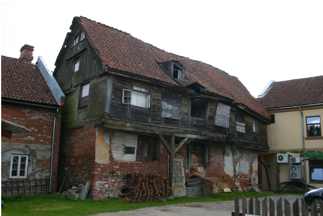
Liepājas_3a_62010060084001_fasade1 Skats uz ēku no ziemeļrietumiem.
