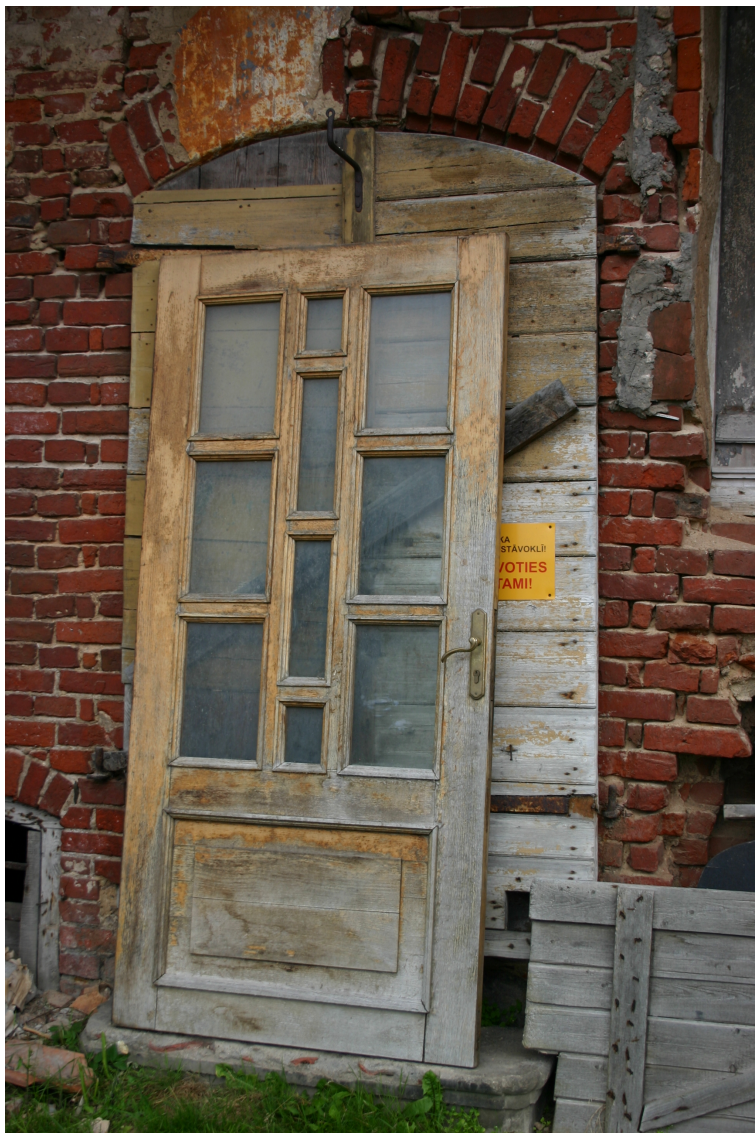
Liepaajas_3a_62010060084001_durvis1 Vēsturiskas durvis (aiz pieslietās vērtnes) ar oriģinālo aprīkojumu.
