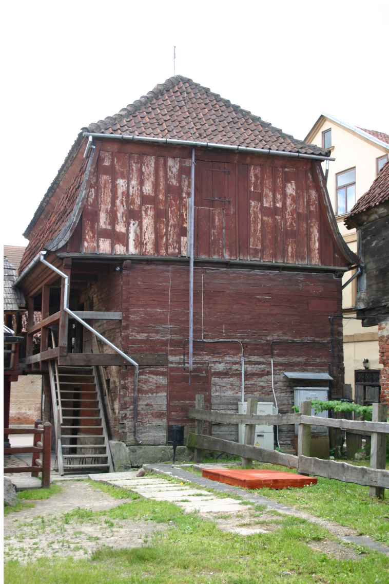
Liepaajas_3_62010060037001_fasade3 Skats uz ēku no ziemeļaustrumiem.
