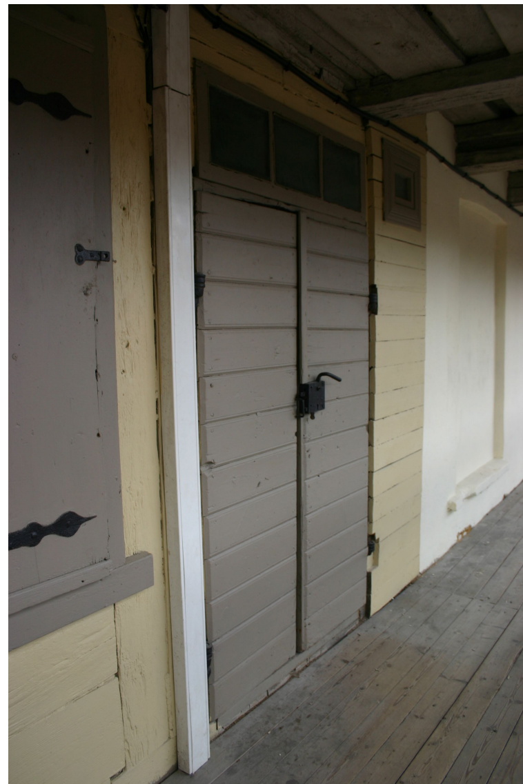
Liepaajas_1_62010060038001_durvis2 19.gs.3.cet. durvju komplekts ar oriģinālo aprīkojumu.
