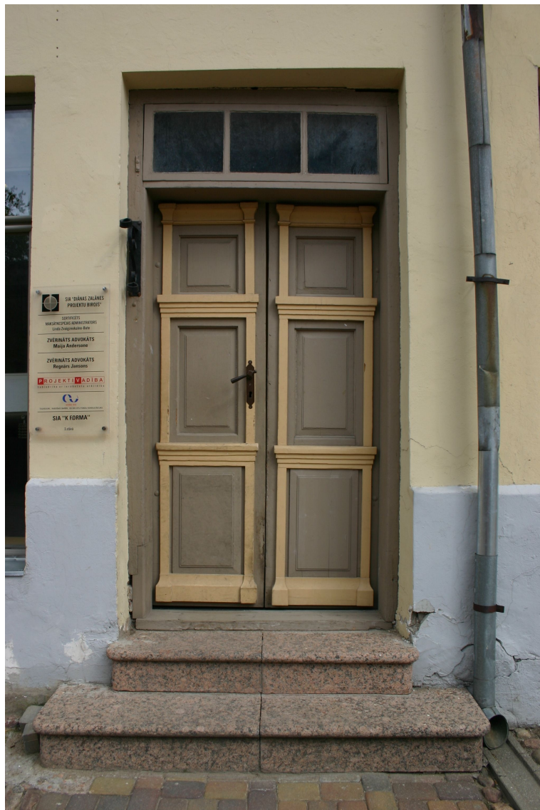
Liepaajas_1_62010060038001_durvis1 19.gs.3.cet. durvju komplekts ar oriģinālo aprīkojumu.
