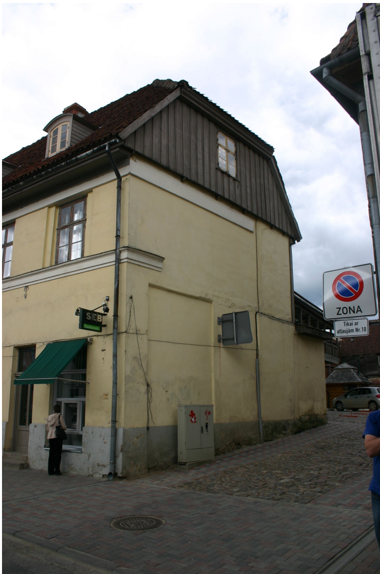
Liepājas_1_62010060038001_fasade5 19.gs.3.cet. uzceltās piebūves ziemeļu fasāde.
