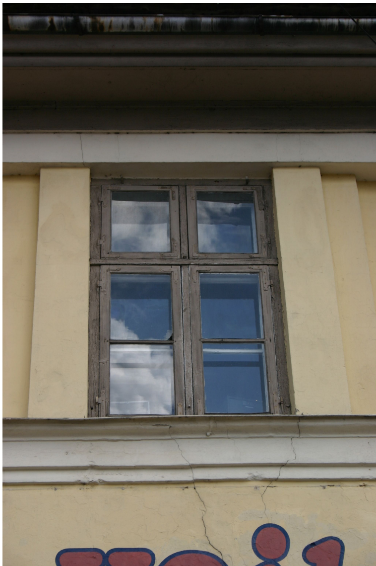
Liepajas_1_62010060038001_logs1 19.gs.3.cet. logs ar oriģinālo aprīkojumu.
