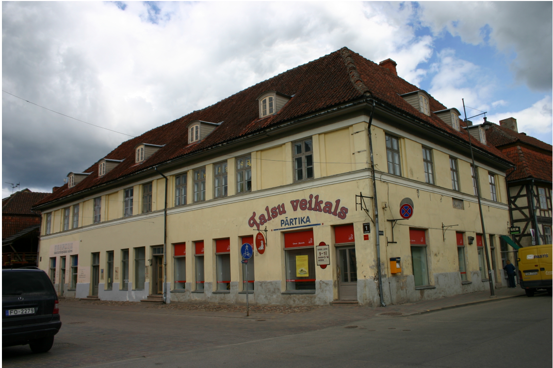
Liepaajas_1_62010060038001_fasade1 Skats uz ēku no dienvidaustrumiem.
