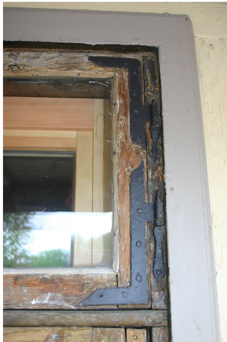
Liepajas_1_62010060038001_logs2 Vēsturiska loga fragments ar 19.gs.1.puses viru kāšiem.
