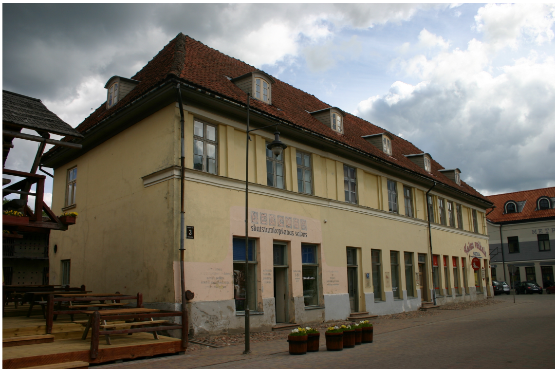
Liepaajas_1_62010060038001_fasade2 Skats uz ēku no dienvidrietumiem.
