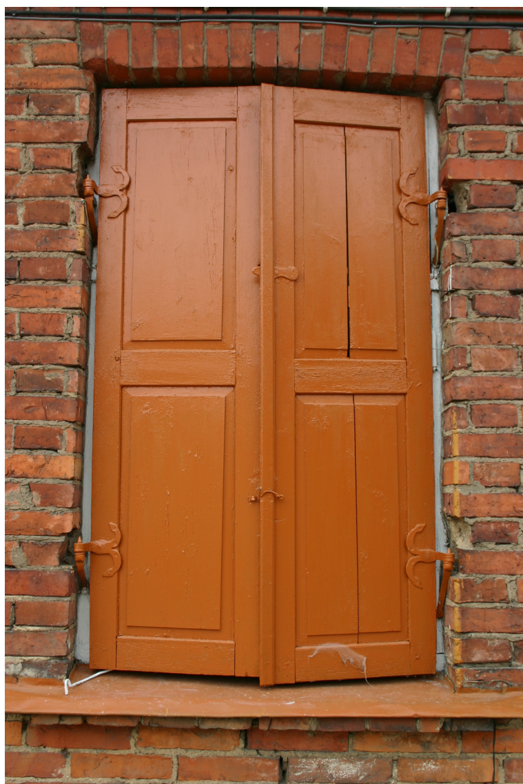
Liepaajas_18_62010140009001_slegi1 _fragments1 Sākotnējie (1904.g.) slēgi ar oriģinālo aprīkojumu.
