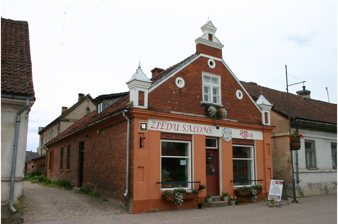
Liepaajas_18_62010140009001_fasade1 Skats uz ēku no ziemeļaustrumiem.
