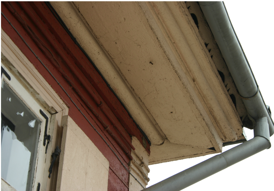
Liepaajas_17_62010090092001_dzega1 1839.-1870to gadu sāk. dēļu dzega un kokā griezts aizsegdēlis.
