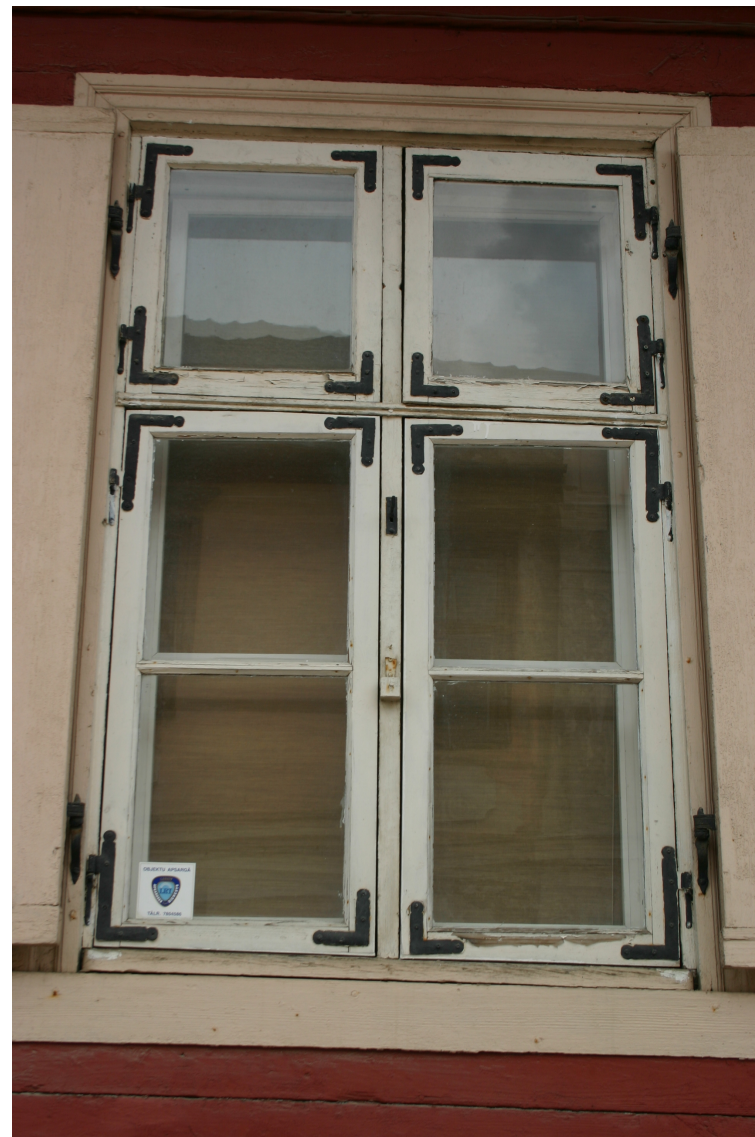
Liepaaajas_17_62010090092001_logs1 Vēsturisks logs ar oriģinālo aprīkojumu.
