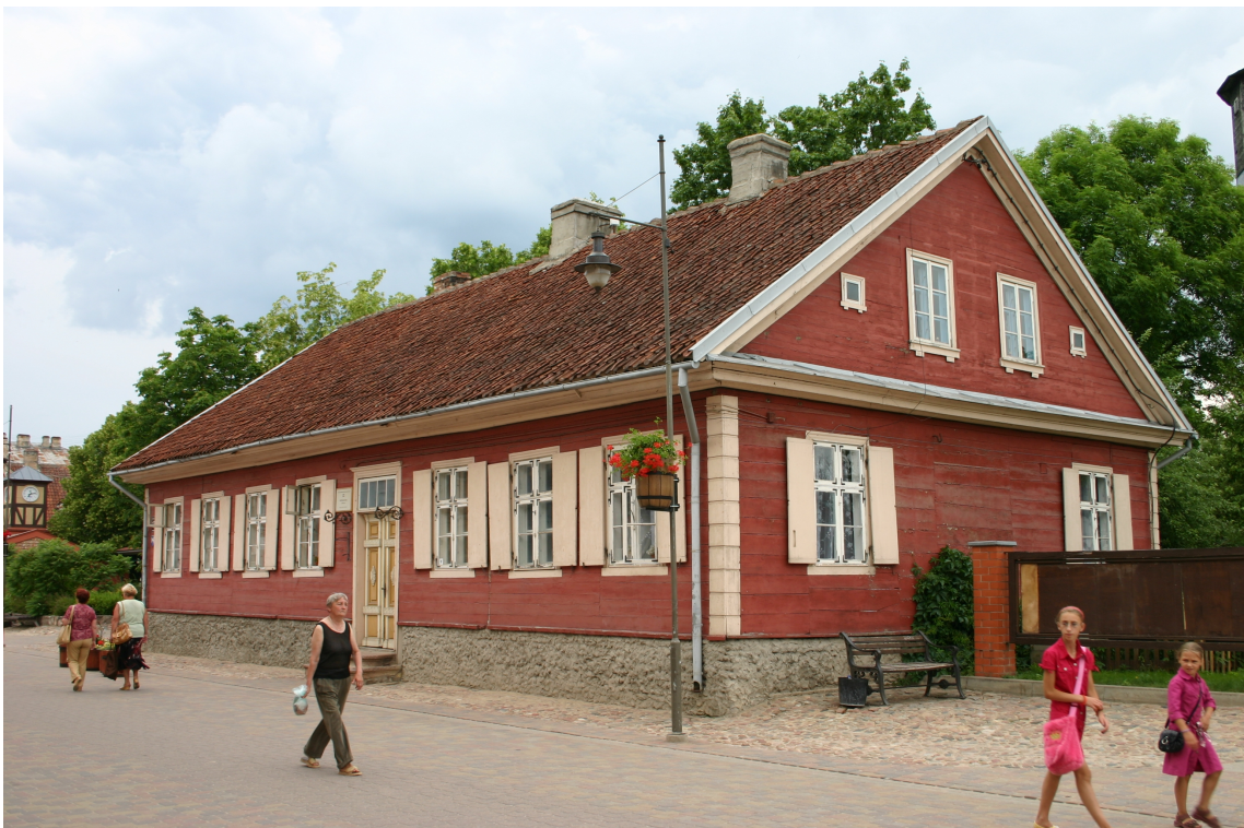
Liepājas_17_62010090092001_fasade2 Skats uz ēku no dienvidaustrumiem.
