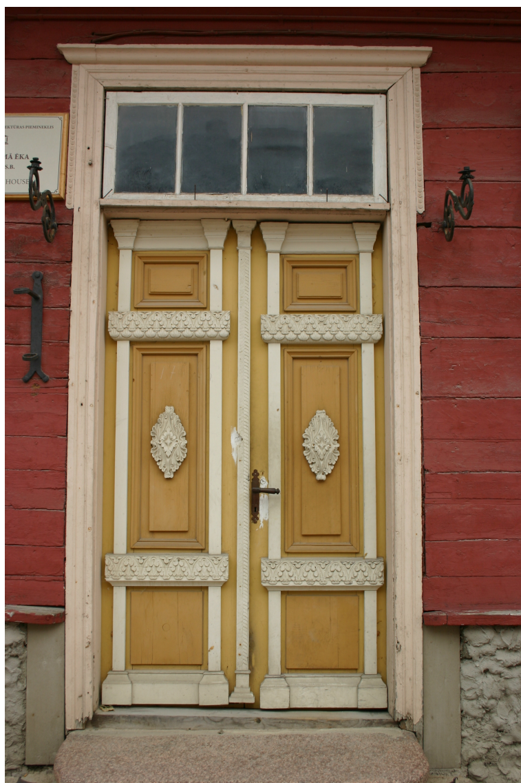
Liepaajas_17_62010090092001_durvis1 19.gs.1.cet. durvju komplekts un apmales. Vērtnes ar zudumiem, stipri labotas. Virslags – 20.gs.2.puse. Aprīkojums - vēsturisks.
