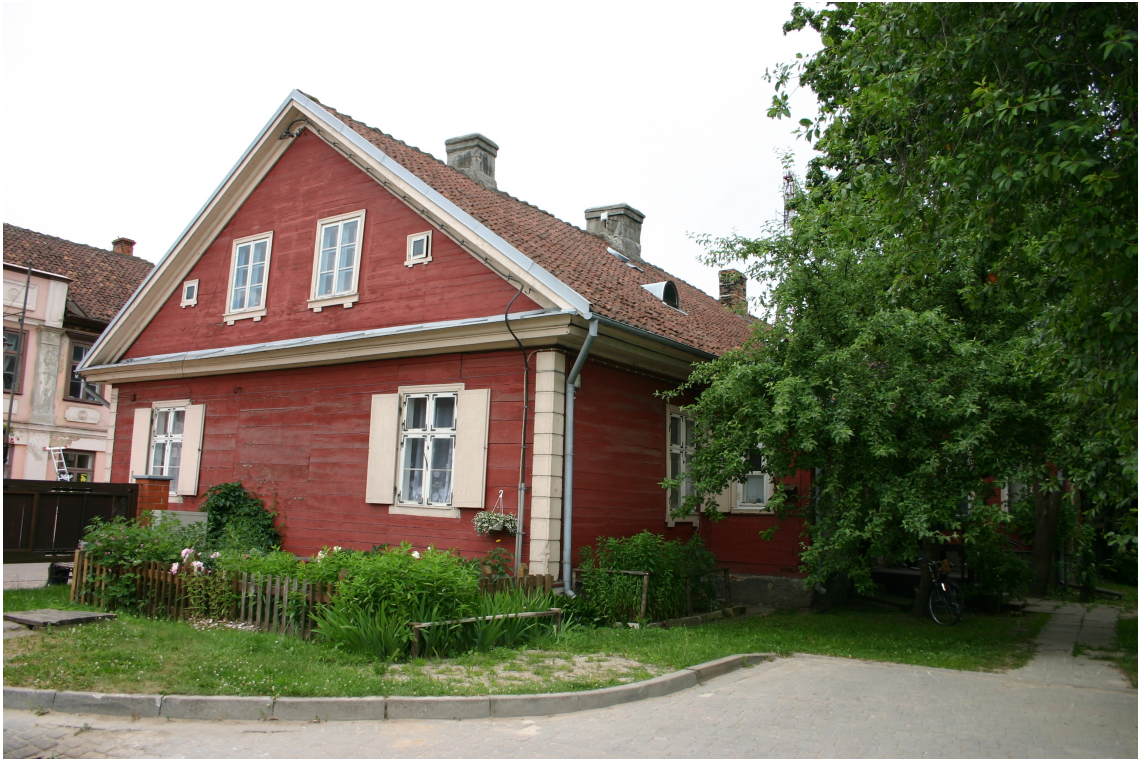
Liepaajas_17_62010090092001_fasade3 Skats uz ēku no ziemeļaustrumiem.
