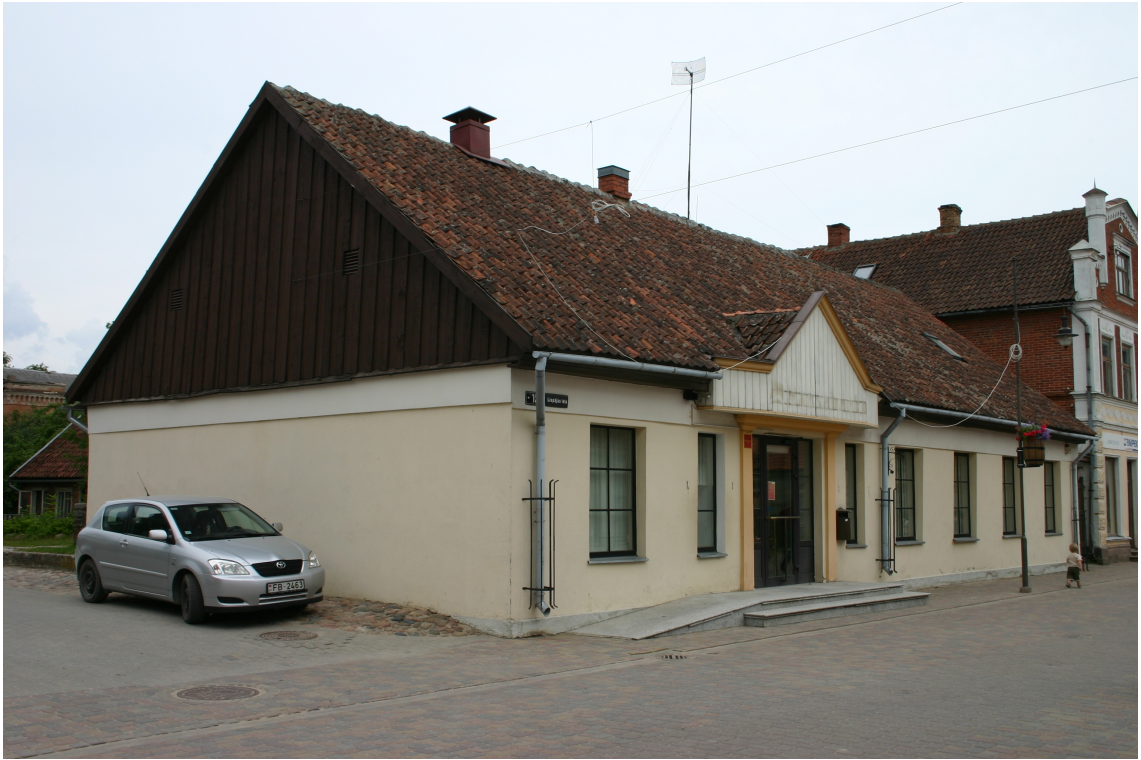
Liepaajas_15_62010090096001_fasade1 Skats uz ēku no dienvidrietumiem.
