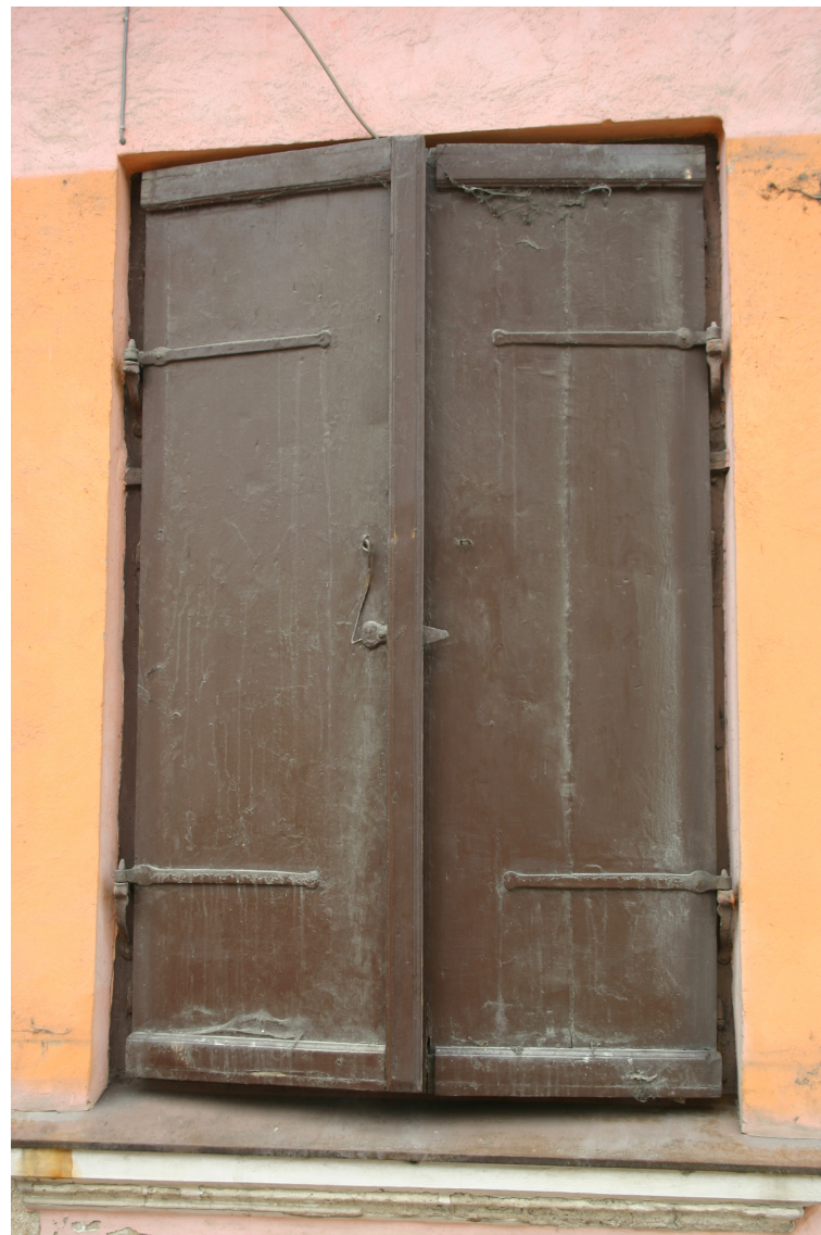
Liepaajas_14b_62010140128001_slegi1 Sākotnēji (19.gs.80.,90.g.) slēgi ar oriģinālo aprīkojumu.
