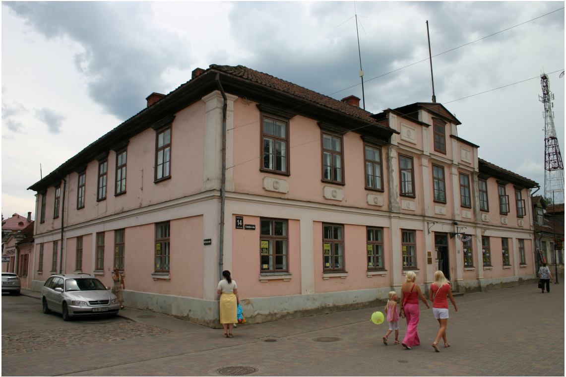
Liepaajas_14_62010140128001_fasade1 Skats uz ēku no ziemeļaustrumiem.
