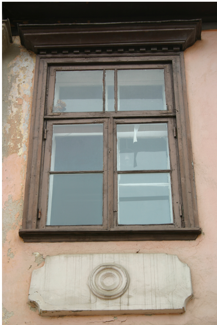
Liepaajas_14_62010140128001_logs1 Sākotnējs (19.gs.3.cet.) logs ar oriģinālo aprīkojumu un aillas dekoratīvā apdare ielas fasādē.
