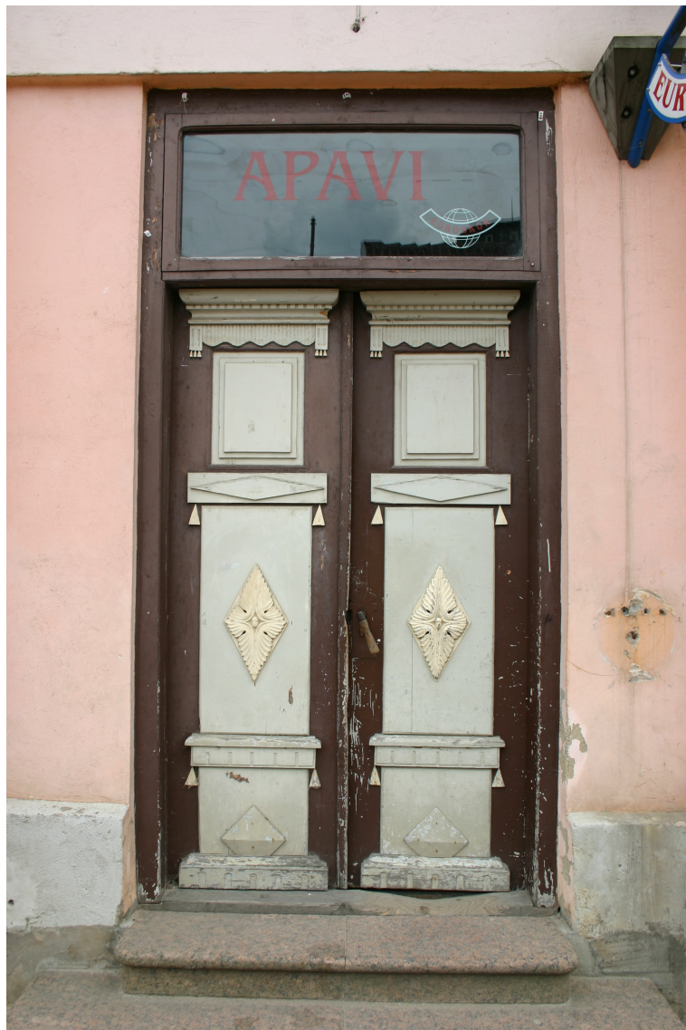
Liepaaļas_14_62010140128001_durvis1 Sākotnējās (19.gs.3.cet.) durvis (stipri labotas) ar oriģinālo aprīkojumu. Virslogs – 20.gs.2.puse.
