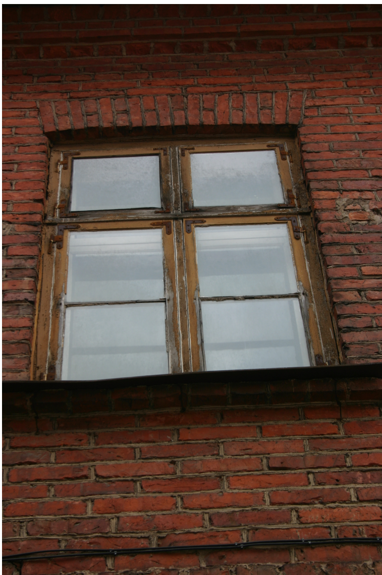
Liepaajas_13_62010090001001_logs2 Sākotnējs (19.gs.beigas) logs ar oriģinālo aprīkojumu.
