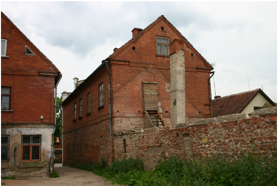
Liepaajas_13_62010090001001_fasade3 Skats uz ēku no ziemeļaustrumiem.
