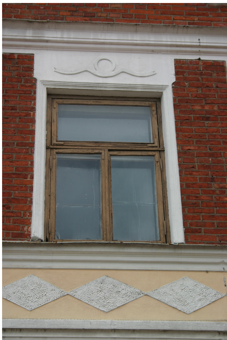
Liepaajas_13_62010090001001_logs1 Sākotnējs (19.gs.beigas) logs ar oriģinālo aprīkojumu un fasādes apdari.
