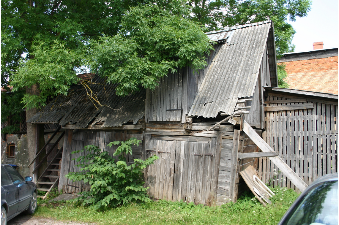
Liepaajas_12_62010140099003_fasade1 Skats uz ēku no dienvidrietumiem.
