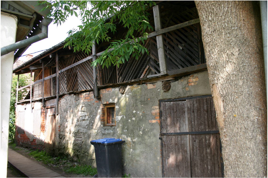
Liepaajas_12_62010140099002_fasade1 Skats uz ēku no dienvidrietumiem.
