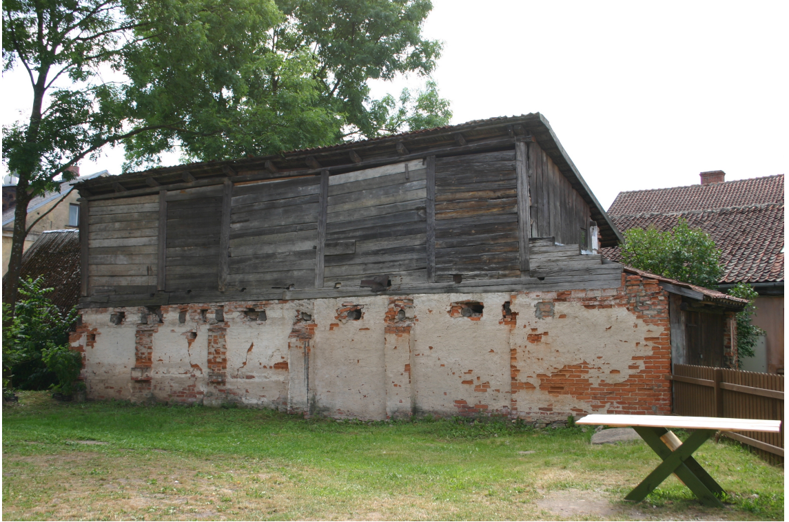
Liepaajas_12_62010140099002_fasade3 Skats uz ēku no ziemeļaustrumiem.
