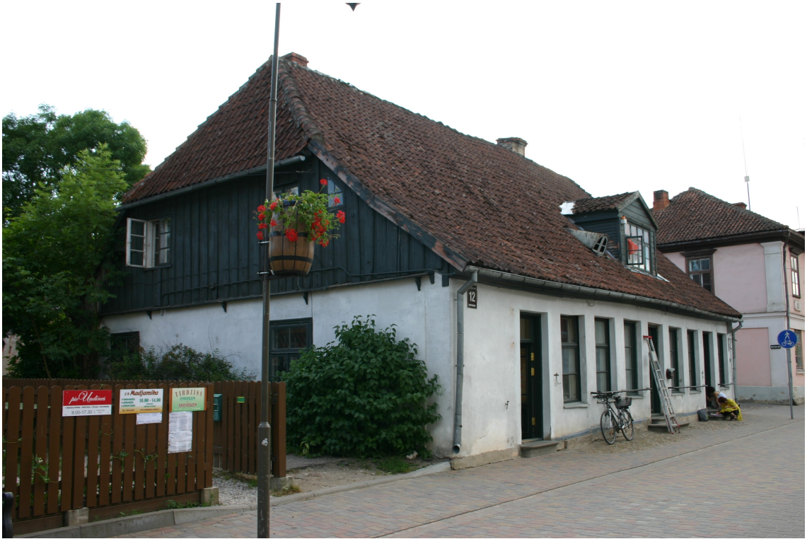
Liepājas_12_62010140099001_fasade1 Skats uz ēku no ziemeļaustrumiem.
