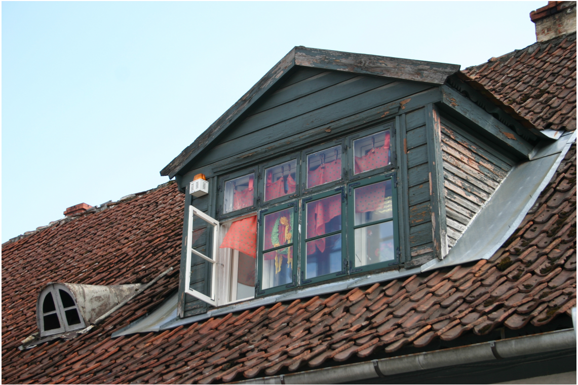
Liepājas_12_62010140099001_fragments1 Vēsturiskas jumta izbūves.
