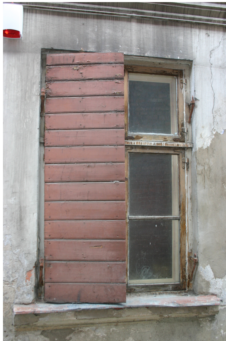
Liepaajas_11_62010090093001_slegi2 Sākotnēji (1902.-1910.g.) slēgi ar oriģinālo aprīkojumu sānu fasādē.
