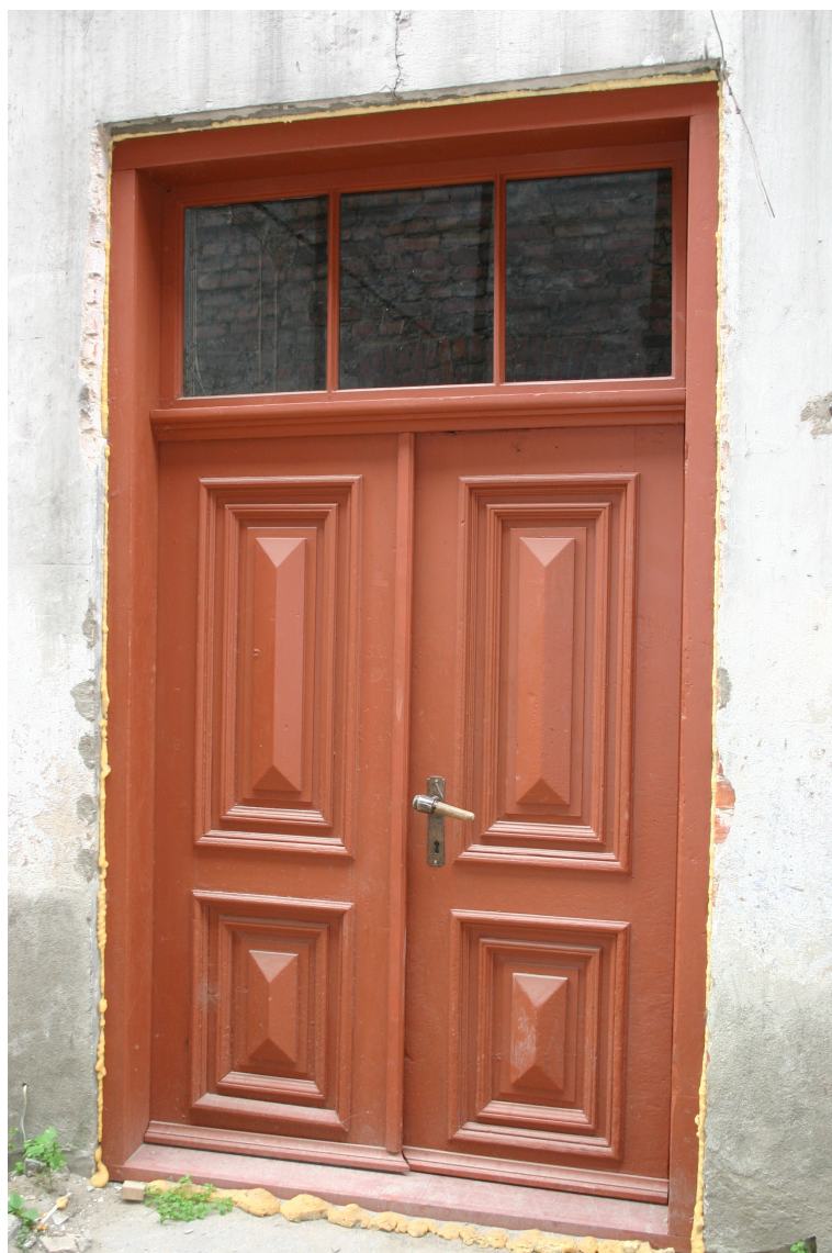
Liepaajas_11_62010090093001_durvis1 Sākotnējs (1902.-1910.g.) durvju komplekts ar oriģinālo aprīkojumu. Virslogs, iespējams, jaunāks.
