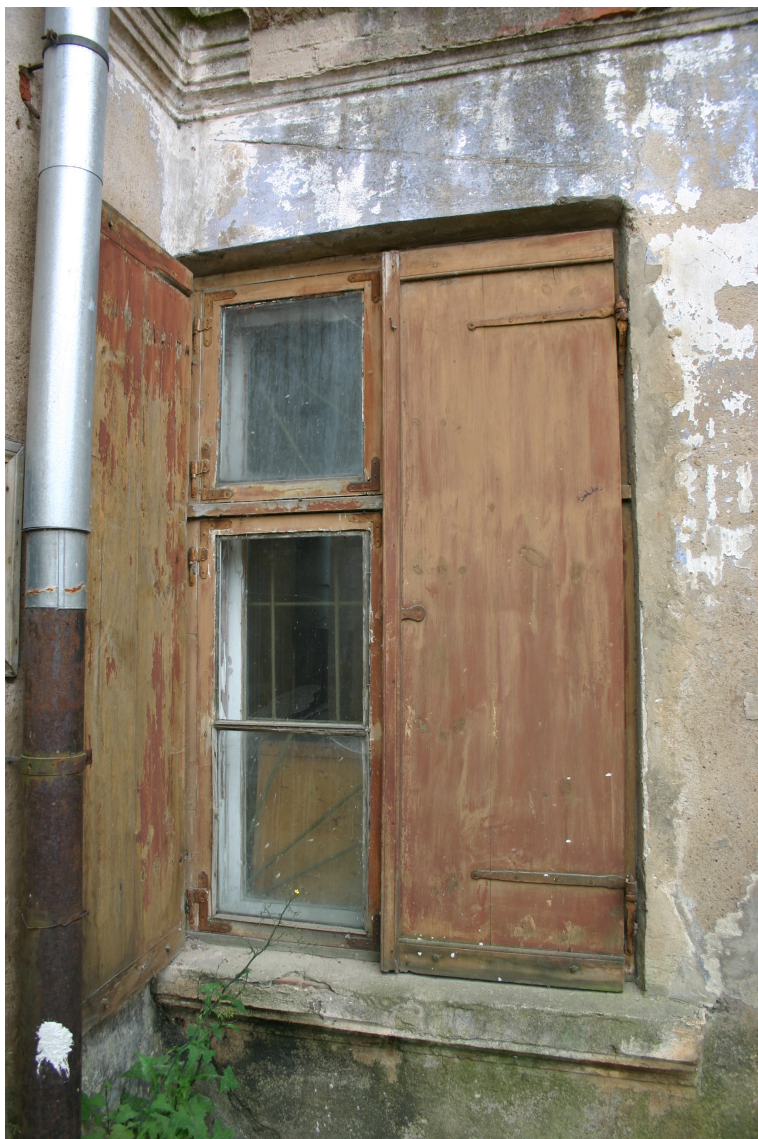
Liepaajas_11_62010090093001_slegi1 Sākotnēji (1902.-1910.g.) slēgi ar oriģinālo aprīkojumu pagalma fasādē.
