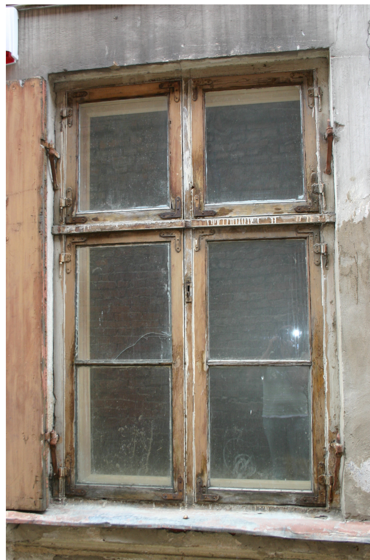
Liepaajas_11_62010090093001_logs1 Sākotnējs (1902.-1910.g.) logs ar oriģinālo aprīkojumu sānu fasādē.
