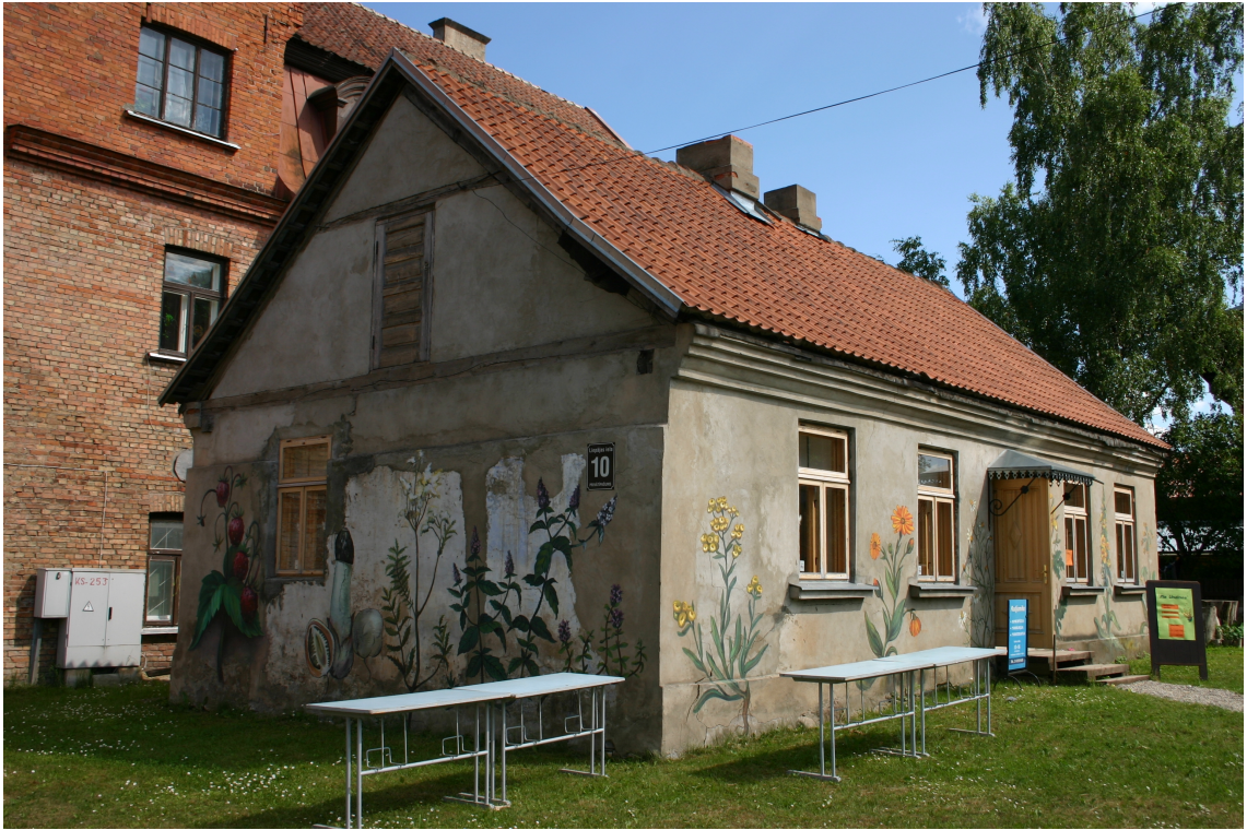
Liepājas_10_62010230015001_fasade1 Skats uz ēku no ziemeļrietumiem.
