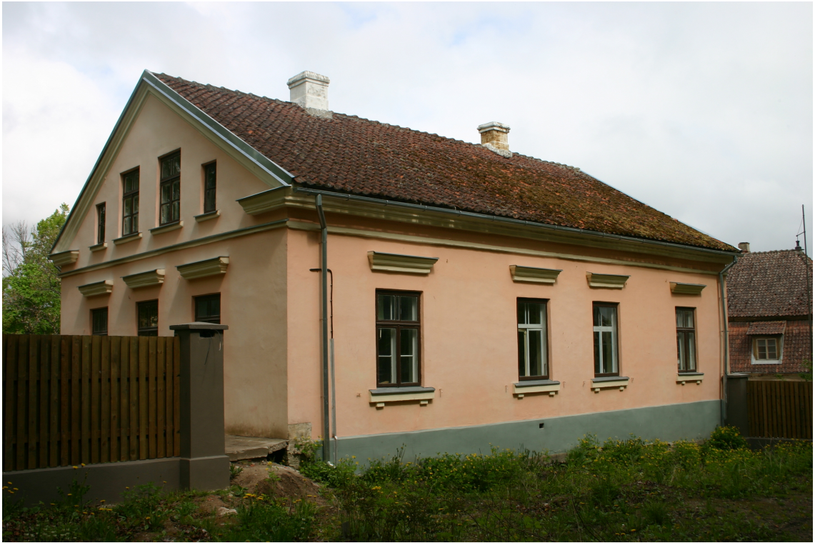
Kalna_27_62010220036001_fasade3 Skats uz ēku no dienvidiem.
