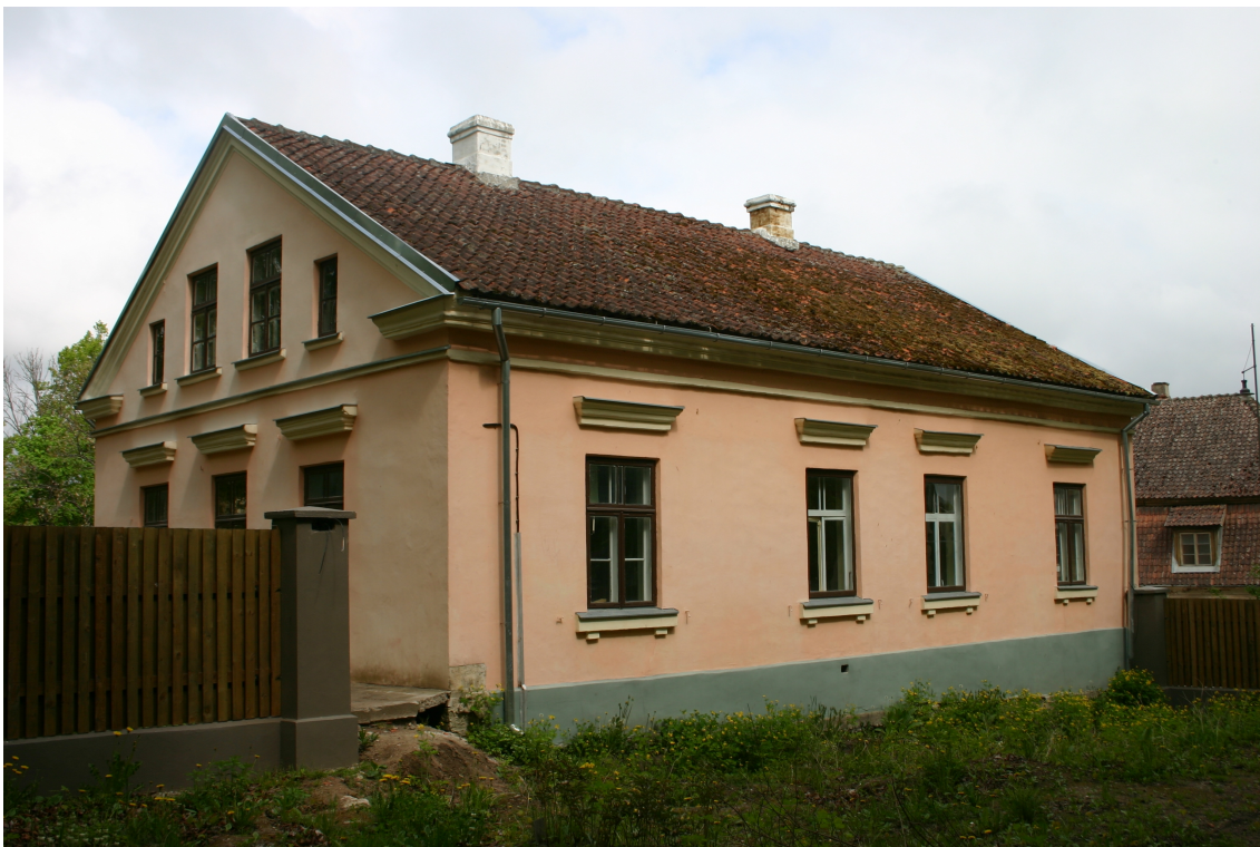
Kalna_27_62010220036001_fasade3 Skats uz ēku no dienvidiem.
