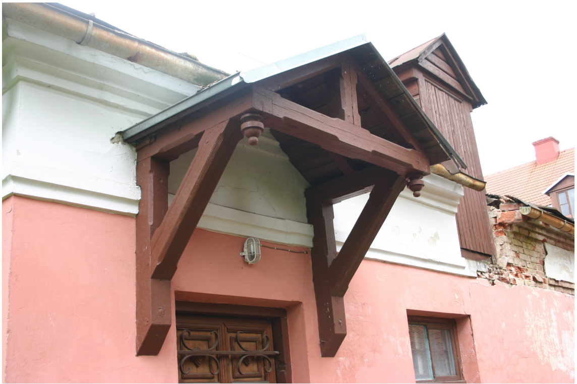
Kalna_25_62010220013003_detala1 Sākotnējs (20.gs.sāk.) jumtiņš virs ieejas austrumu fasādē.
