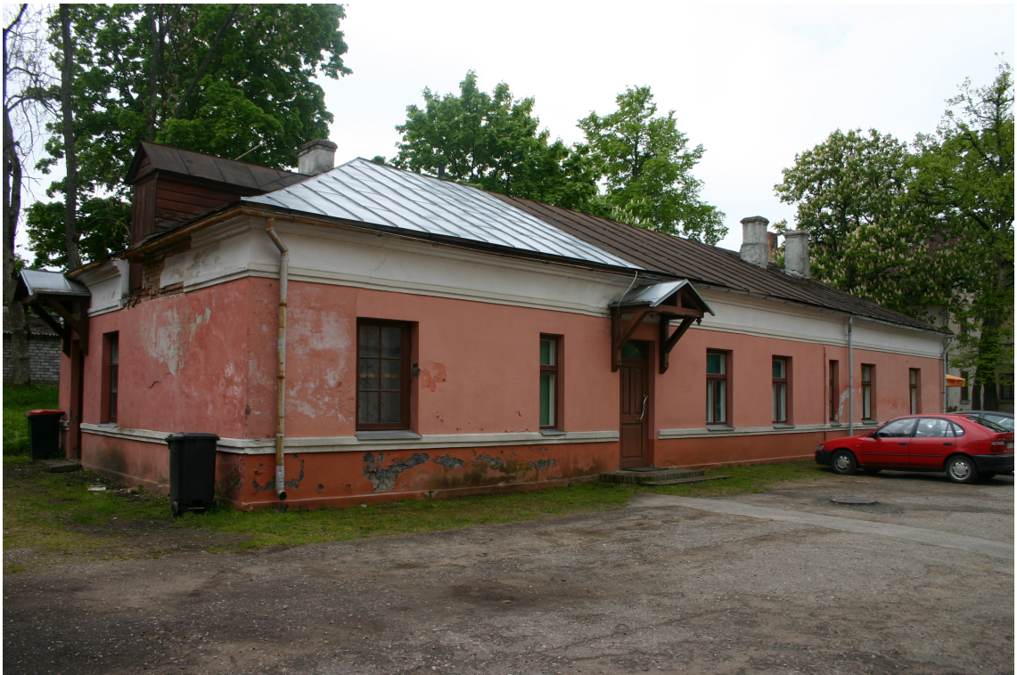
Kalna_25_62010220013003_fasade2 Skats uz ēku no ziemeļaustrumiem.
