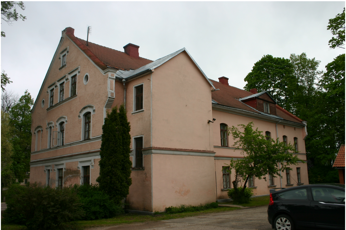
Kalna_25_62010220013001_fasade2 Skats uz ēku no dienvidrietumiem.
