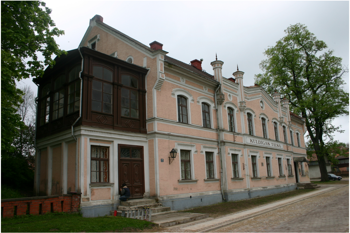
Kalna_25_62010220013001_fasade1 Skats uz ēku no ziemeļaustrumiem.
