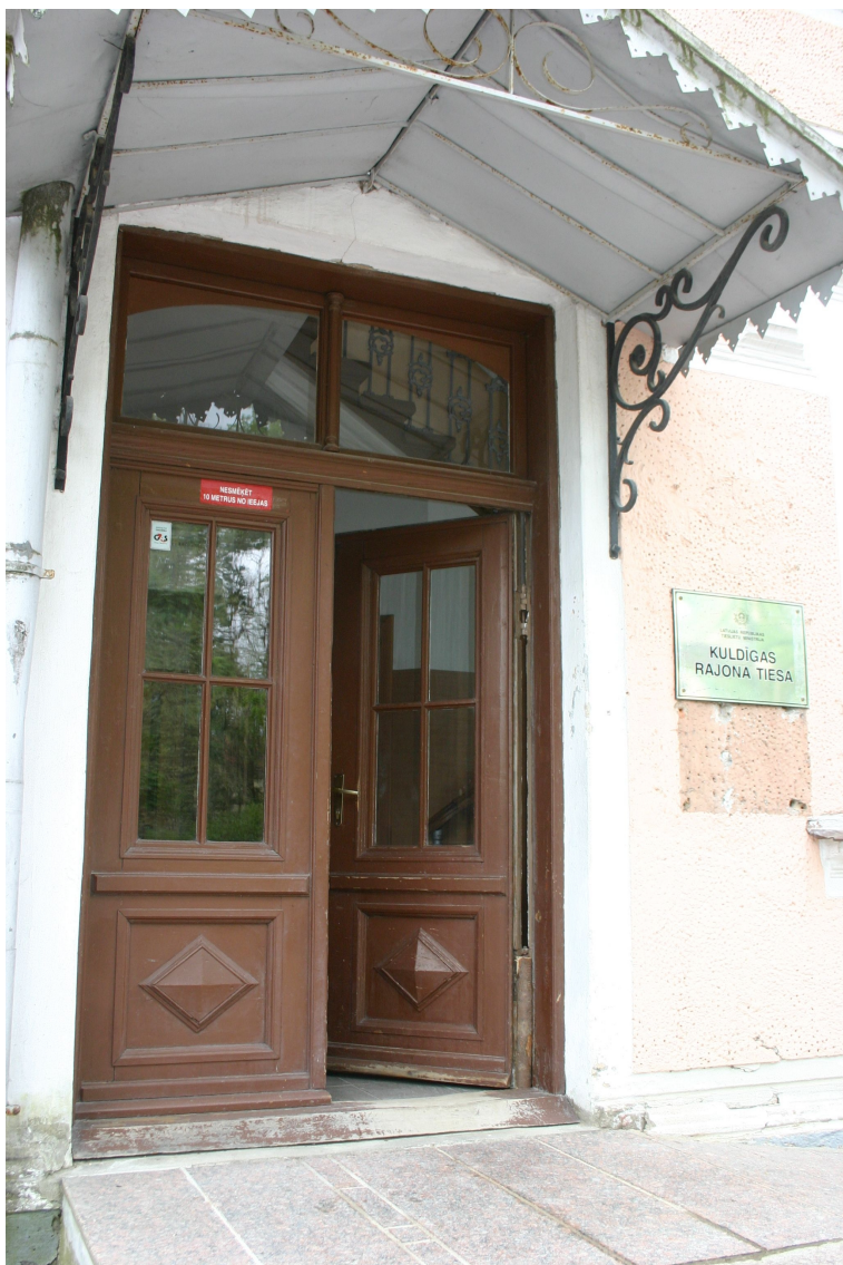
Kalna_25_62010220013001_durvis1 Sākotnējo (ap 1880.g.) durvju komplekts un jumtiņa konsoles. Pārējās jumtiņa detaļas – 20.gs.2.puse.
