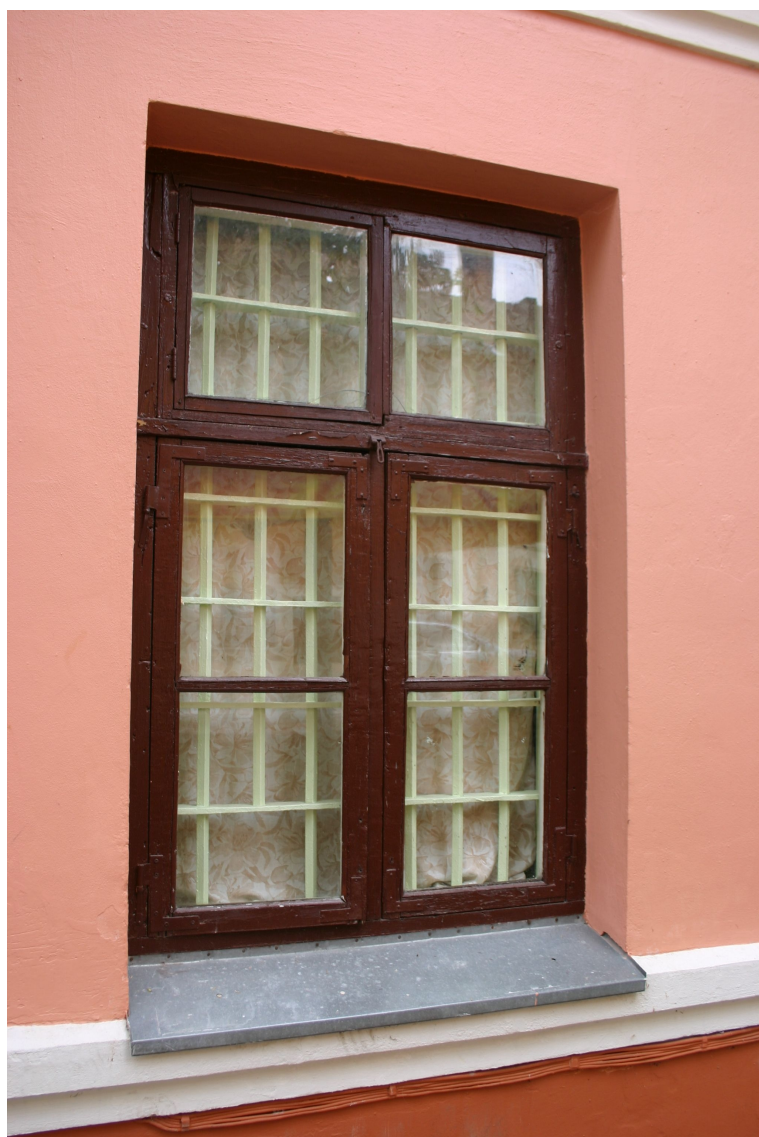
Kalna_25_62010220013003_logs1 Sākotnējs (20.gs.sāk.) logs ar oriģinālo aprīkojumu.
