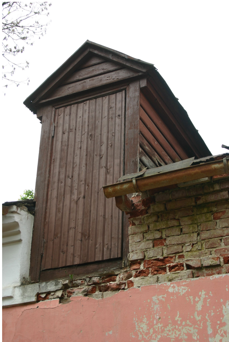
Kalna_25_62010220013003_fragments1 Sākotnēja (20.gs.sāk.) izbūve. Durvis - 20.gs.2.puse.
