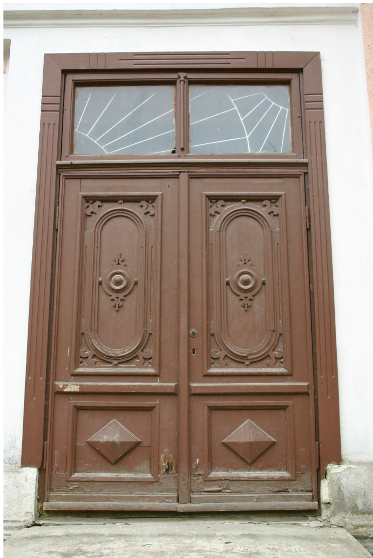
Kalna_25_62010220013001_durvis2 Sākotnējo (ap 1880.g.) durvju komplekts ar daļēji saglabājušos aprikojumu.
