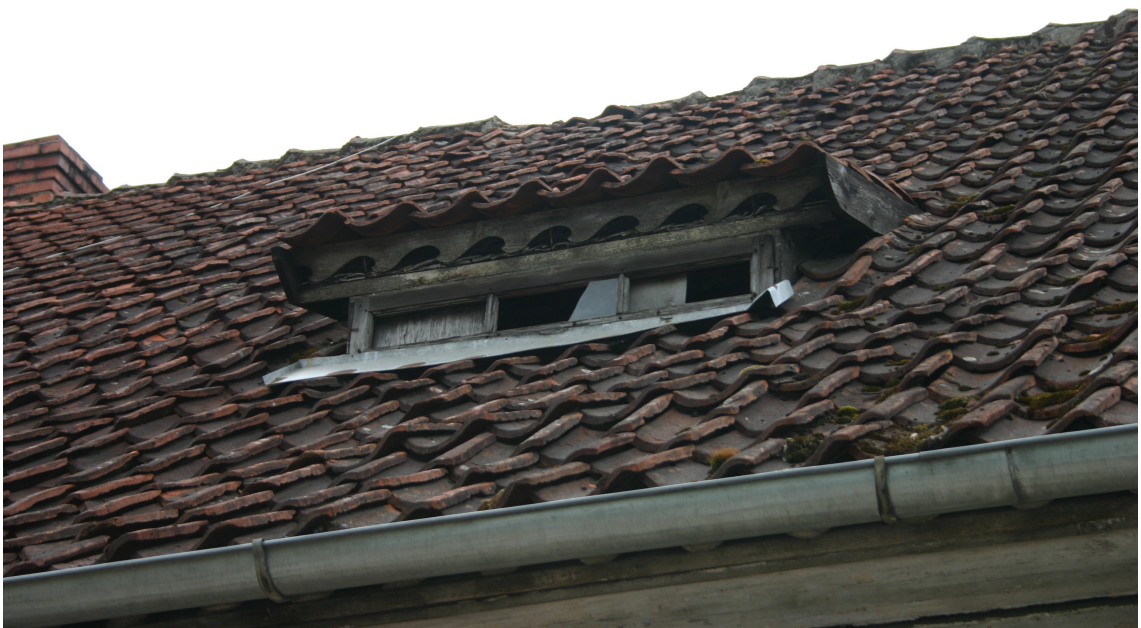
Kalna_23_62010220029001_jumts1 Sākotnēja (19.gs.vidus) jumta izbūve.
