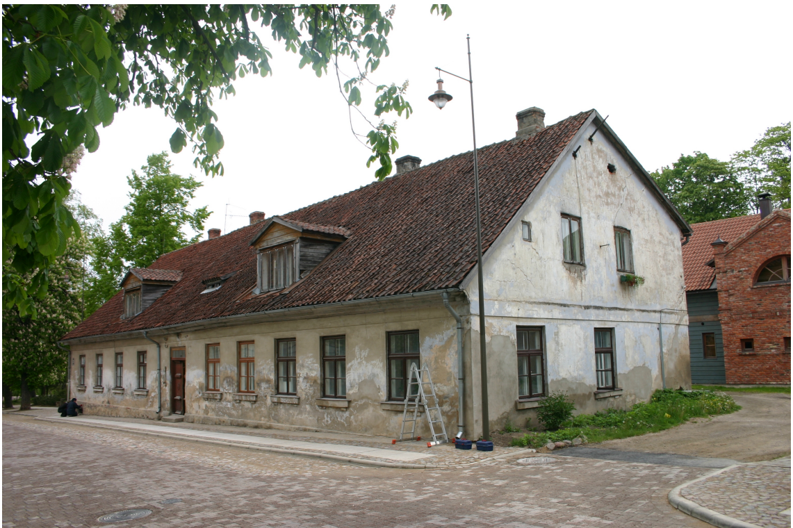
Kalna_23_62010220029001_fasade2 Skats uz ēku no dienvidrietumiem.
