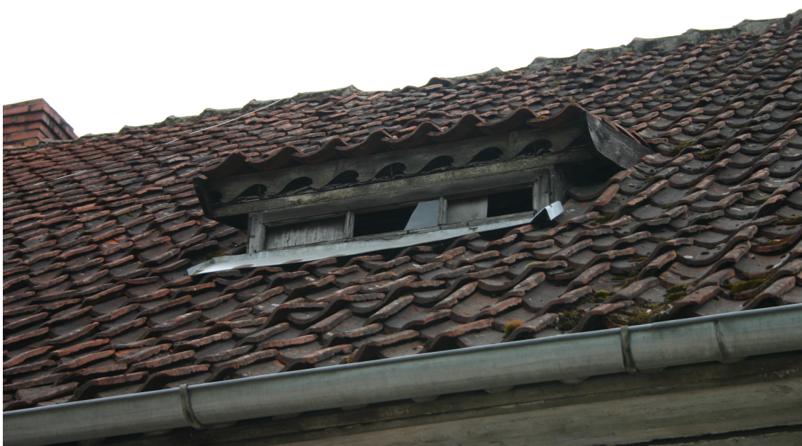
Kalna_23_62010220029001_jumts1 Sākotnēja (19.gs.vidus) jumta izbūve.
