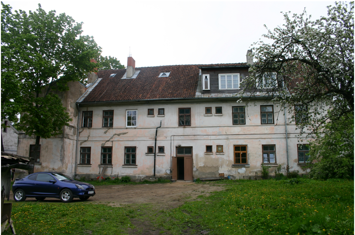
Kalna_20_62010220058001_fasade4 Ēkas rietumu fasāde.
