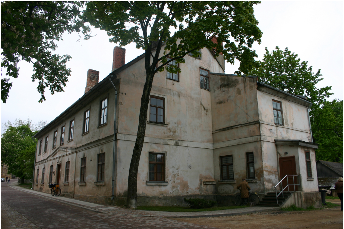
Kalna_20_62010220058001_fasade2 Skats uz ēku no ziemeļaustrumiem. Vienstāvīgā piebūve uzcelta 20.gs.2.pusē.
