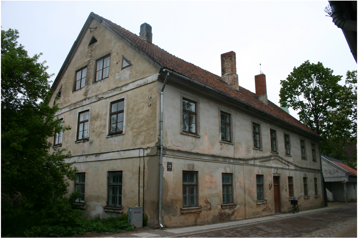
Kalna_20_62010220058001_fasade1 Skats uz ēku no dienvidaustrumiem.
