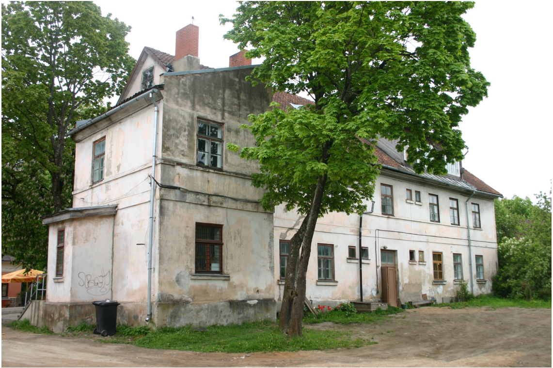
Kalna_20_62010220058001_fasade3 Skats uz ēku no ziemeļrietumiem.
