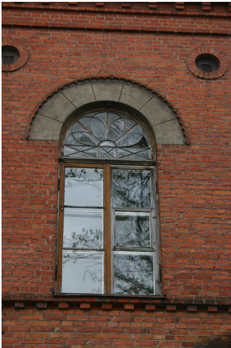
Kalna_19_62010220042001_logs2 Sākotnējs (1866.g.) logs ar oriģinālo aprīkojumu.
