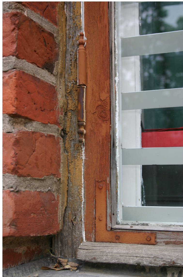
Kalna_19_62010220042001_logs3 Sākotnējs (1866.g.) loga aprīkojums.
