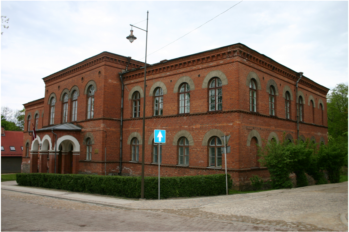
Kalna_19_62010220042001_fasade1 Skats uz ēku no dienvidrietumiem.
