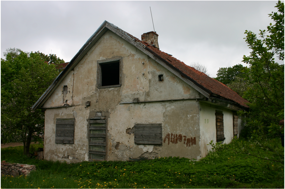
Kalna_18_62010220035001_fasade3 Skats uz ēku no dienvidrietumiem.
