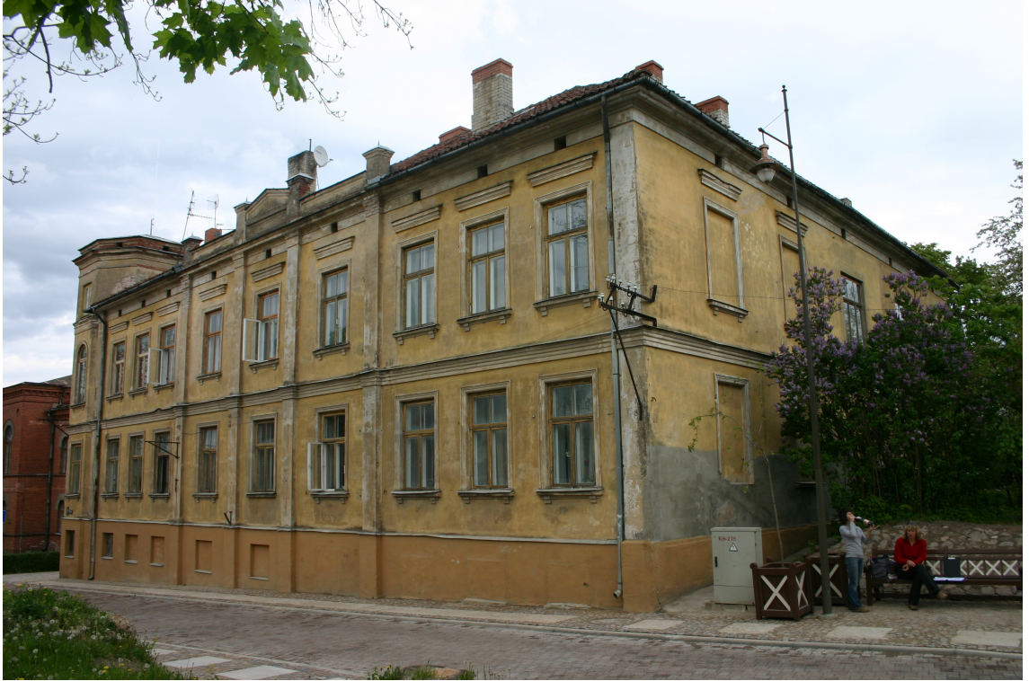
Kalna_17_62010220055001_fasade1 Skats uz ēku no dienvidrietumiem.
