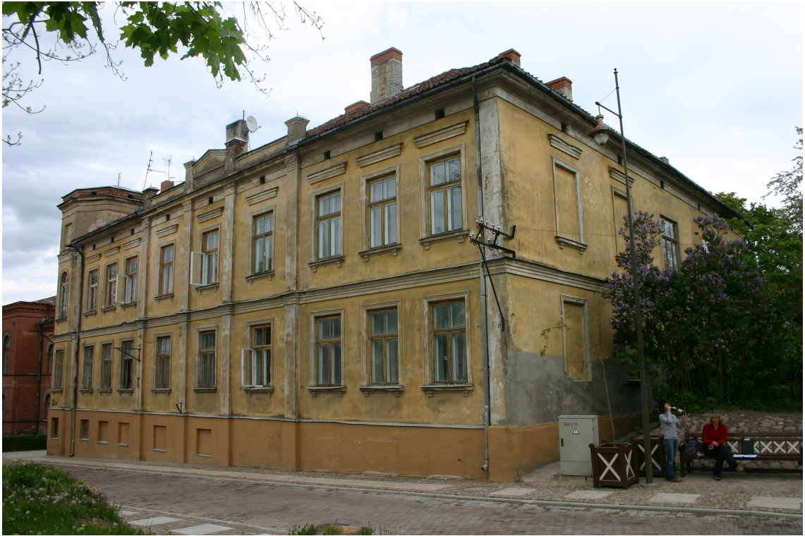
Kalna_17_62010220055001_fasade1 Skats uz ēku no dienvidrietumiem.
