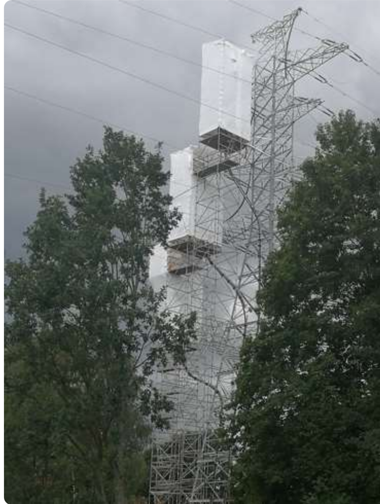
Balsts pirms un pēc kabeļa ievades zemē; būvniecības process. Kabeļu balsti ir masīvāki par gaisvadu līniju balstiem
