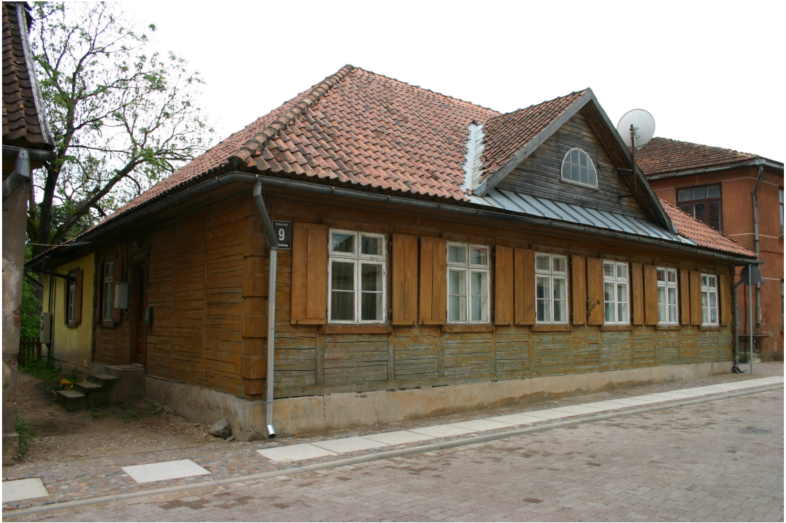
Kalna_9_62010220067001_fasade1 Skats uz ēku no ziemeļrietumiem.
