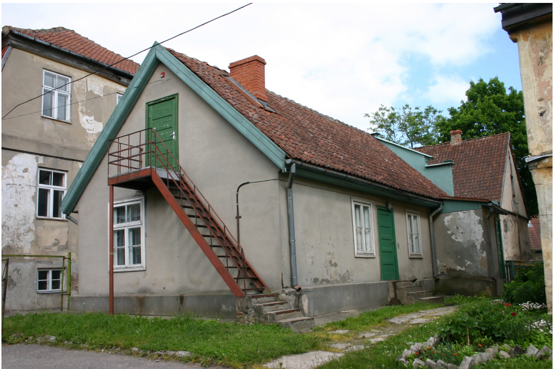
Kalna_4_62010220095001_fasade4 Skats uz ēku no rietumiem.
