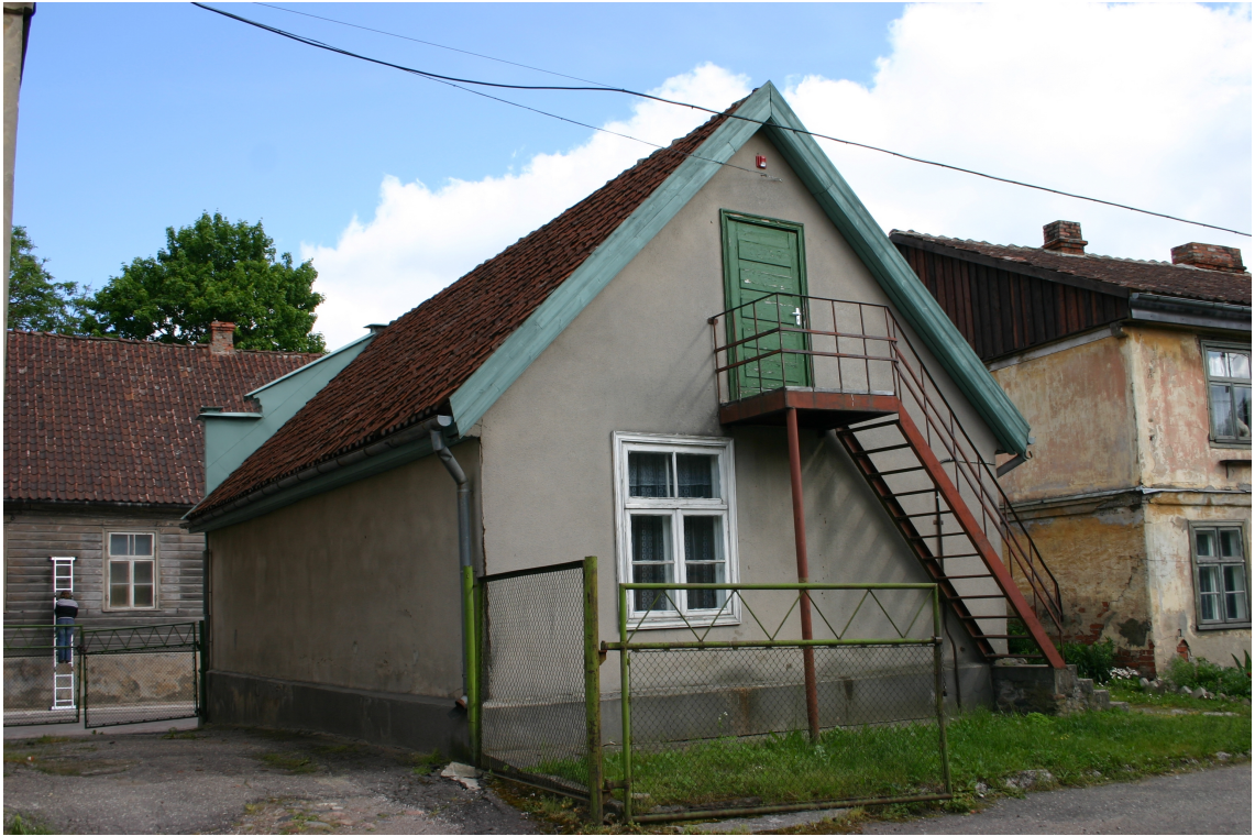
Kalna_4_62010220095001_fasade3 Skats uz ēku no ziemeļiem.
