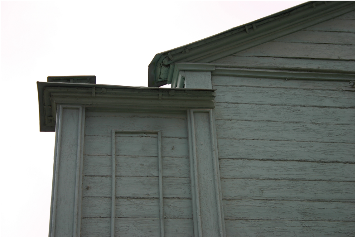
Kalna_4_62010220095001_fragments1 19.gs.2.pusē izveidotās apdares fragments galvenajā fasādē.
