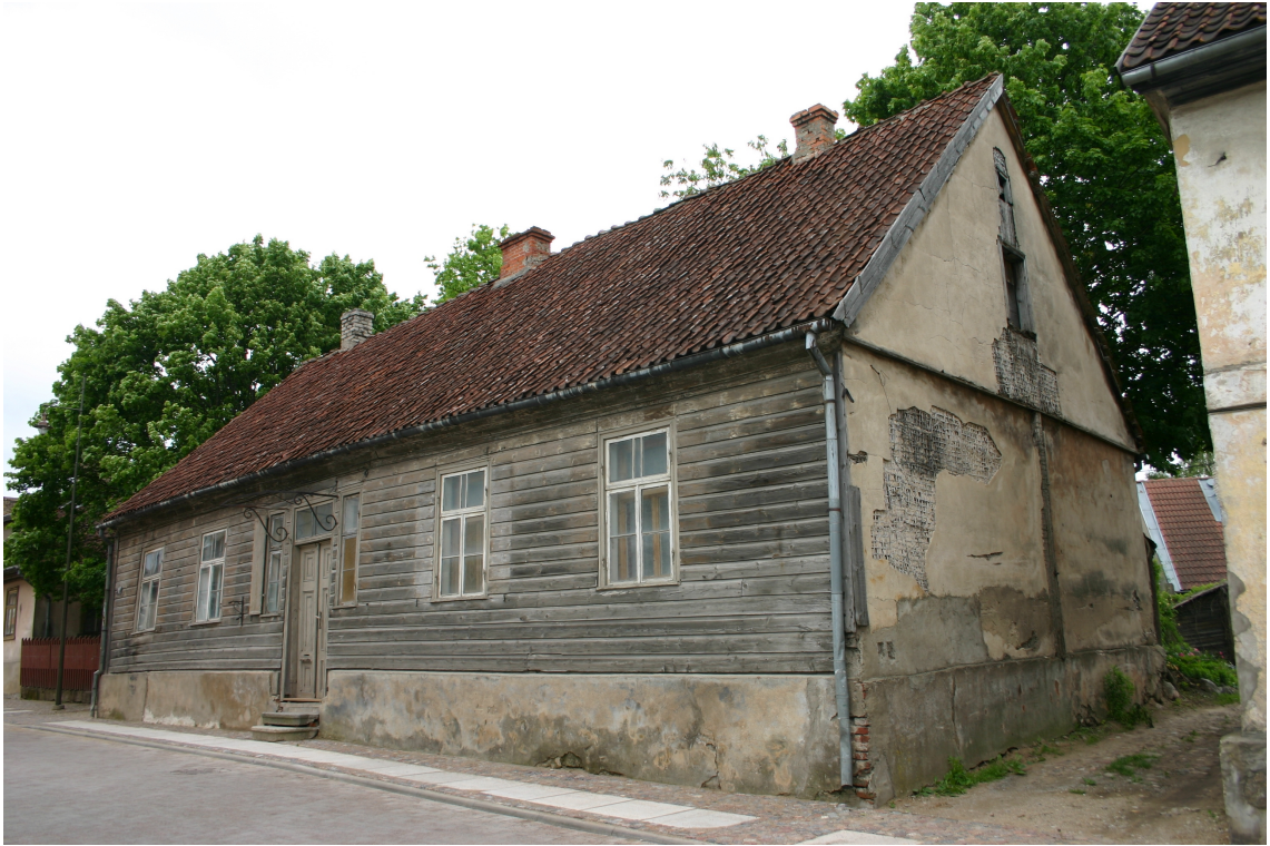
Kalna_3_62010220033001_fasade1 Skats uz ēku no dienvidrietumiem.
