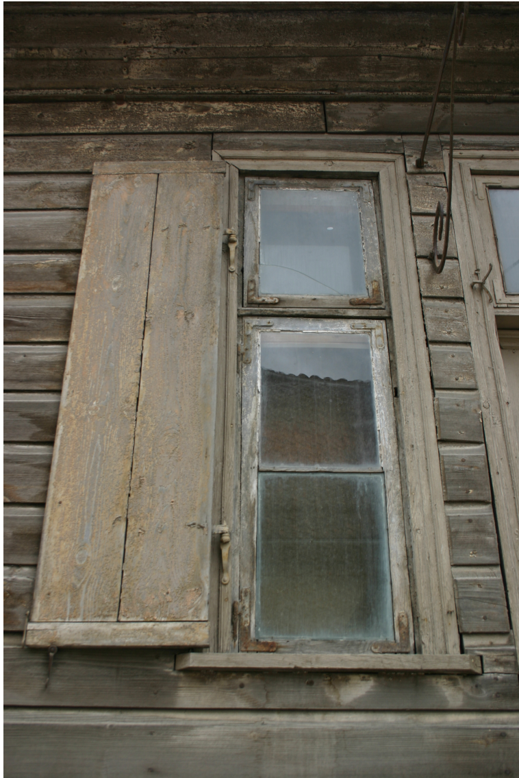
Kalna_3_62010220033001_logs1 Sākotnējs (19.gs.3.cet.) logs un slēģis ar oriģinālo aprīkojumu un apmales.
