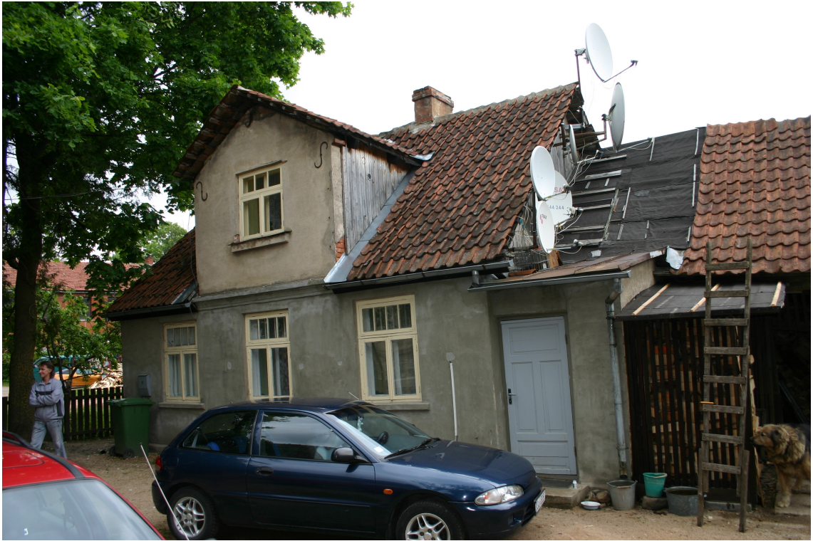
Kalna_3_62010220033002_fasade1 Skats uz ēku no dienvidrietumiem.
