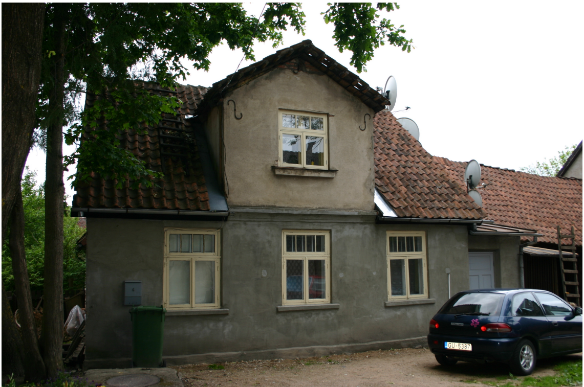
Kalna_3_62010220033002_fasade2 Skats uz ēku no rietumiem.
