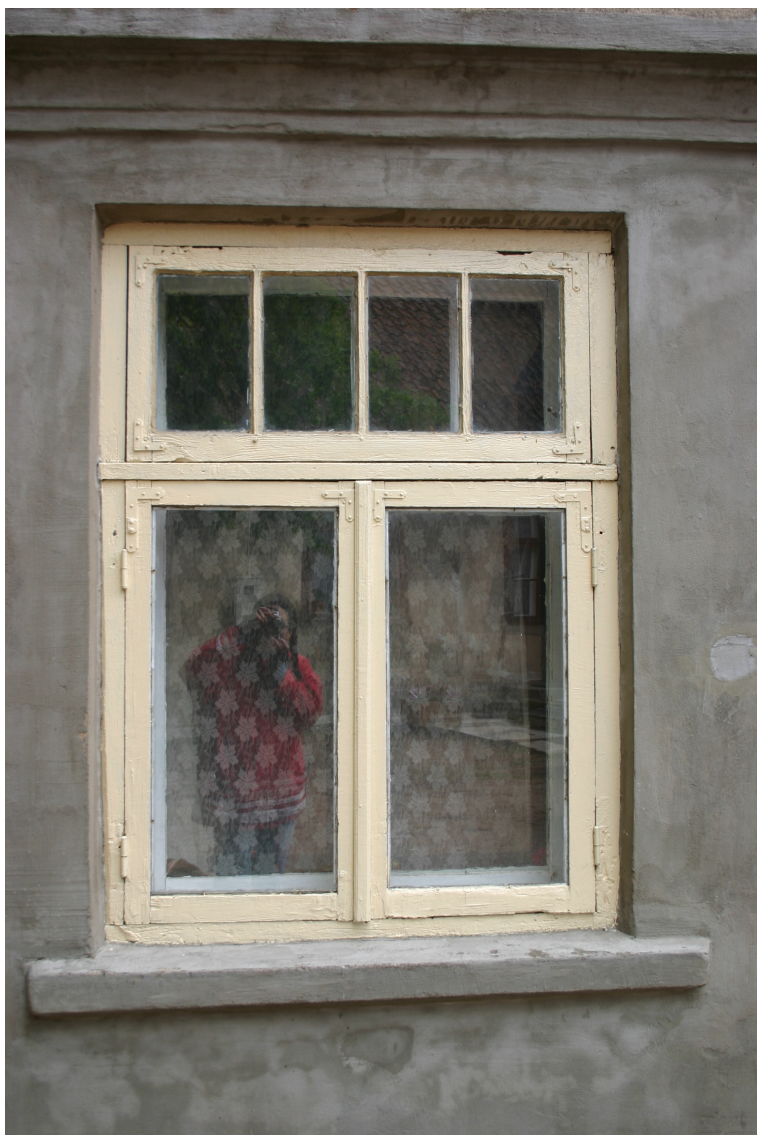
Kalna_3_62010220033002_logs1 Sākotnējs (20.gs.1.puse) logs ar oriģinālo aprīkojumu.
