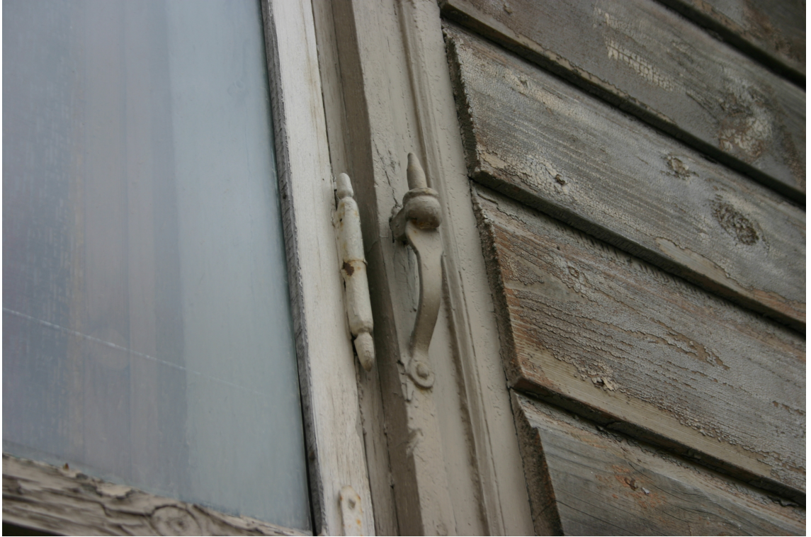
Kalna_3_62010220033001_logs3 Domājams, sākotnējais (19.gs.3.cet.) loga un slēga aprīkojums.
