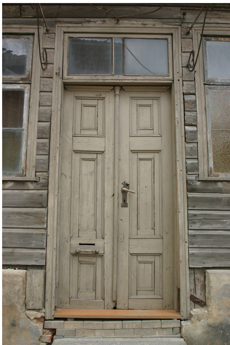
Kalna_3_62010220033001_durvis1 Sākotnējo (19.gs.3.cet.) durvju komplekts ar oriģinālo aprīkojumu.
