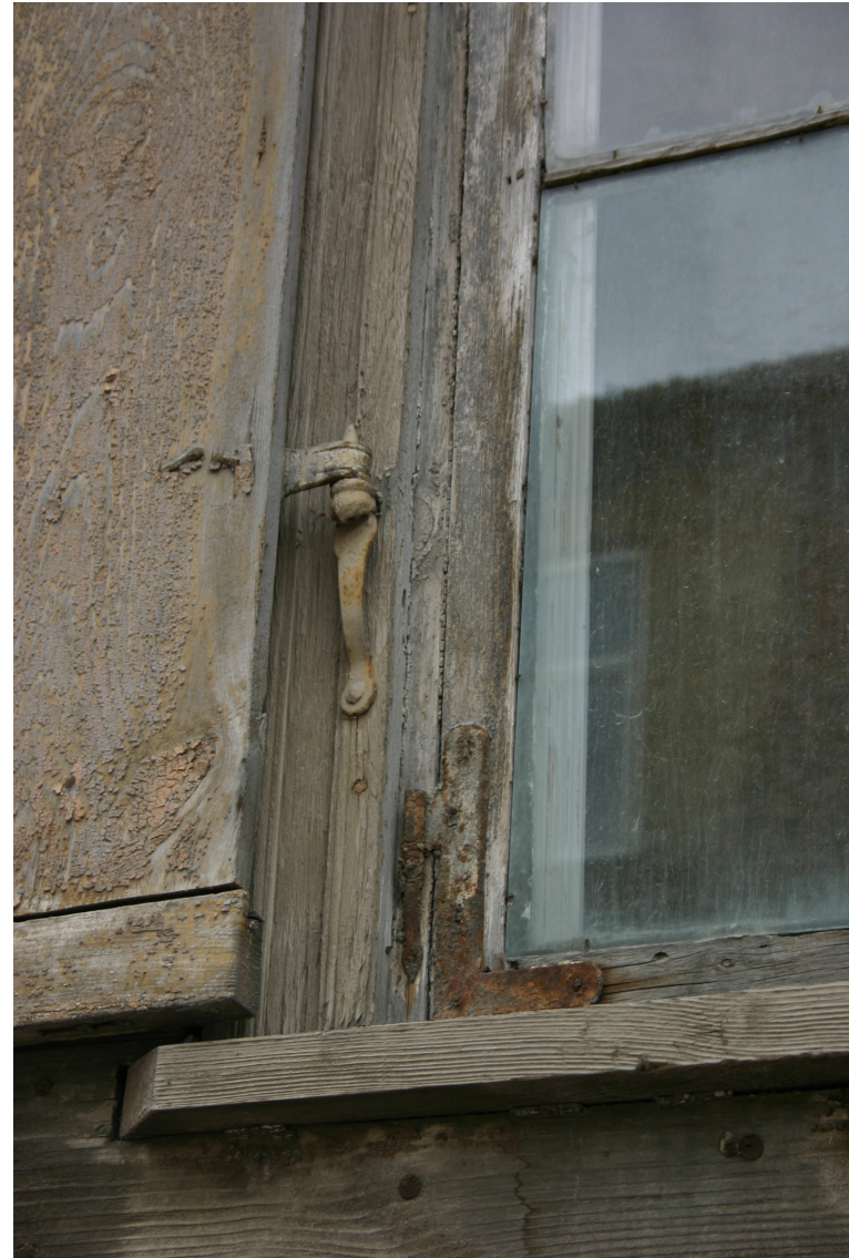
Kalna_3_62010220033001_logs2 Sākotnējais (19.gs.3.cet.) loga un slēģa aprīkojums.
