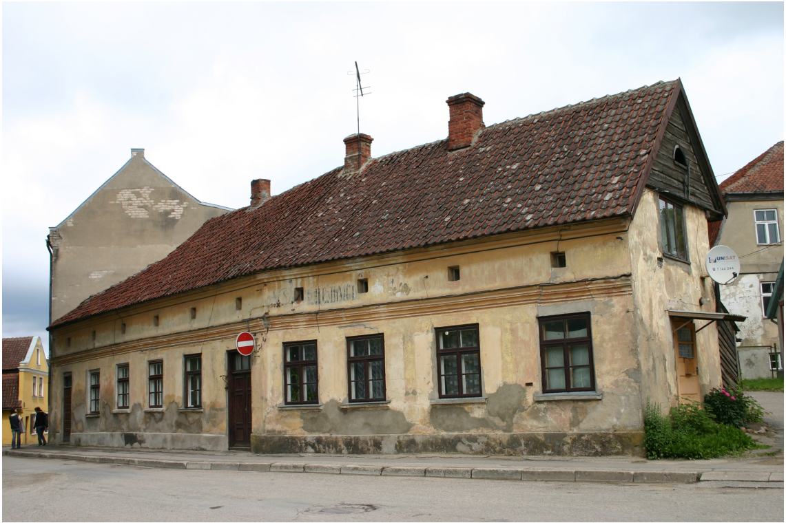
Kalna_2_62010220057002_fasade1 Skats uz ēku no dienvidrietumiem.
