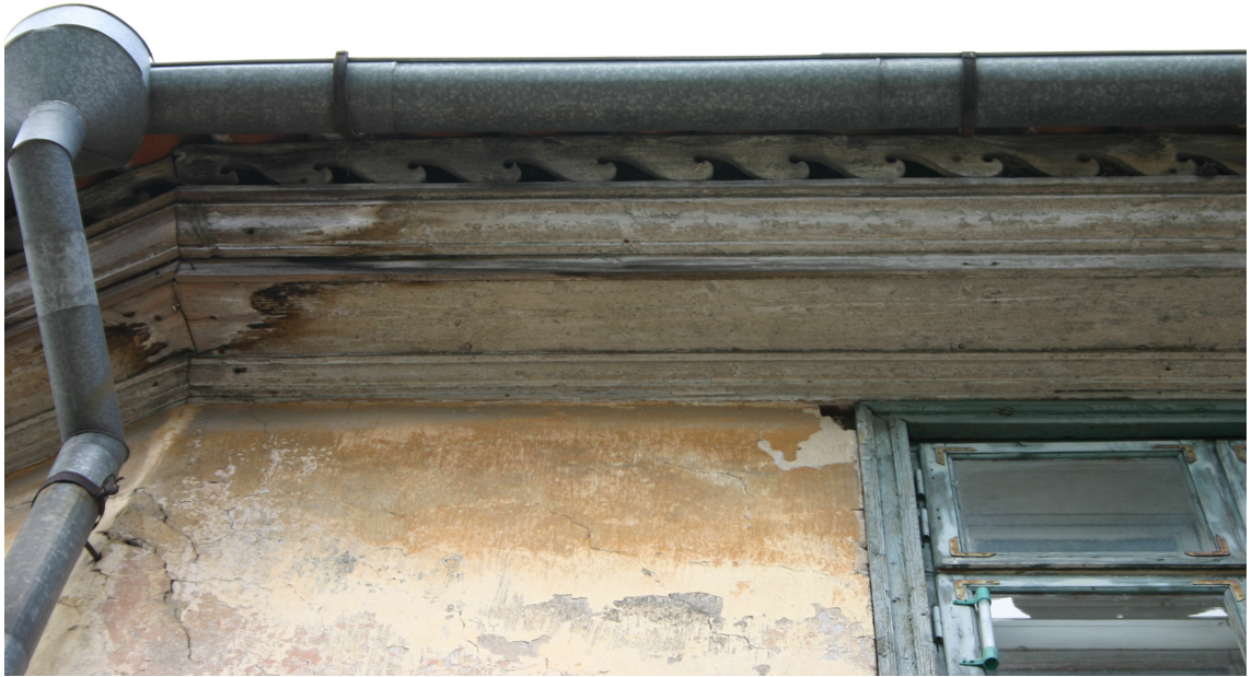
Kalna_2_62010220057001_dzega1 19.gs.3.cet. dēļu dzega un kokā griezts aizsegdēlis.
