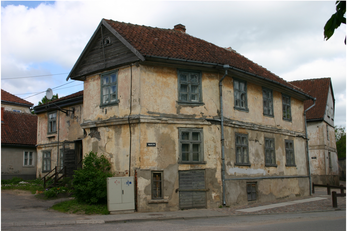
Kalna_2_62010220057001_fasade3 Ēka skatā no rietumiem. 2.stāvs, piebūve un apdare – 19.gs.3.cet.
