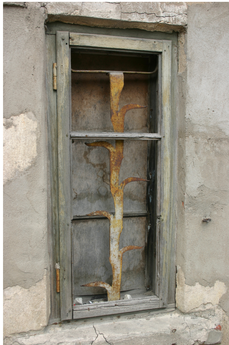
Kalna_2_62010220057001_restes1 Atkārtoti izmantotas vēsturiskas metāla restes.
