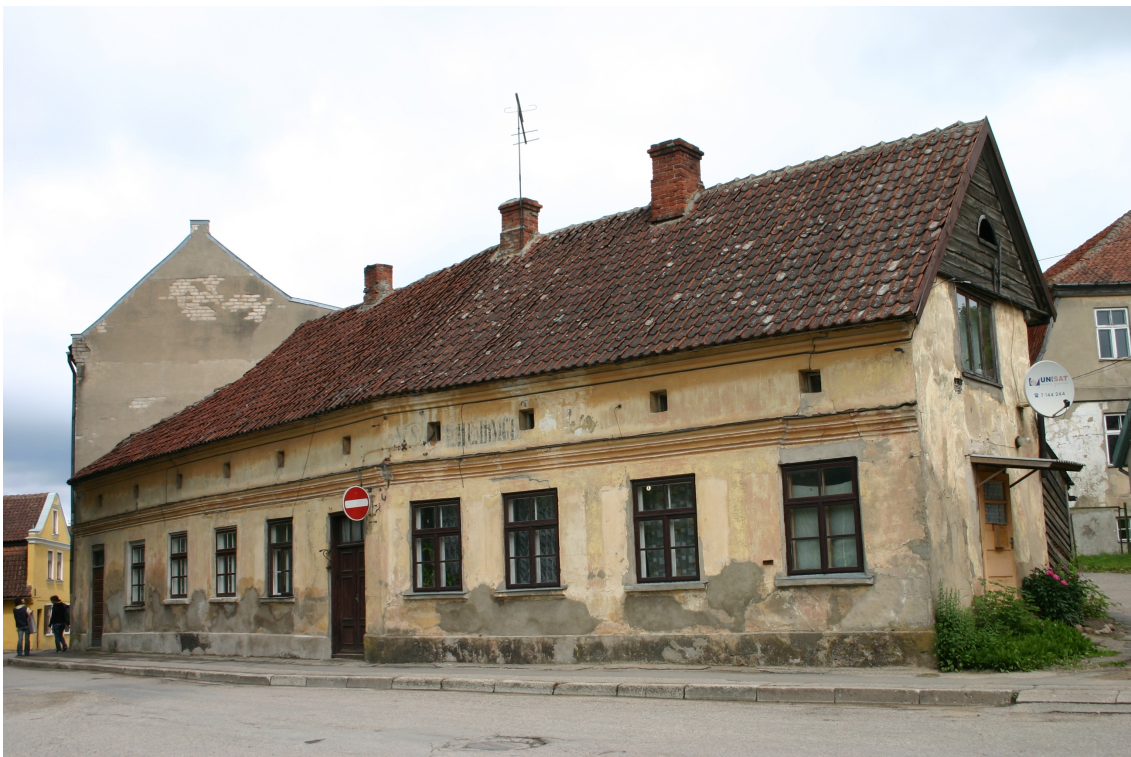
Kalna_2_62010220057002_fasade1 Skats uz ēku no dienvidrietumiem.
