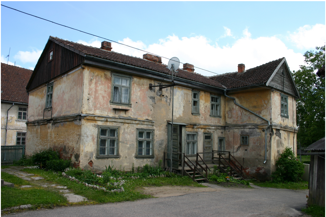
Kalna_2_62010220057001_fasade4 Ēka skatā no ziemeļiem. 2.stāvs, piebūve un apdare – 19.gs.3.cet.
