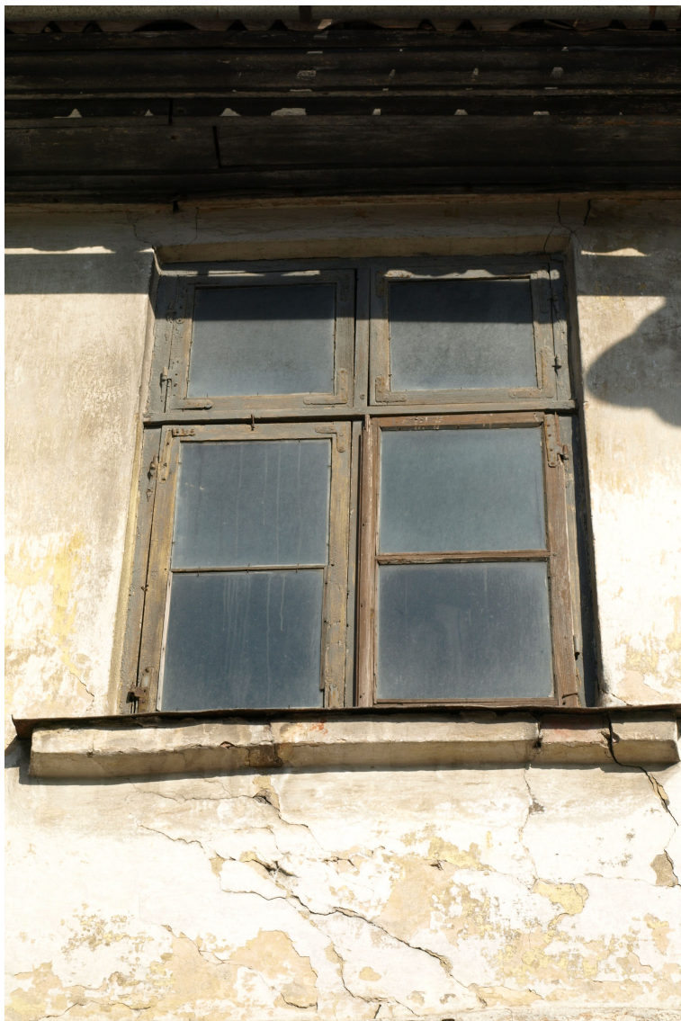
Kalna1_62010220070001_logs1 Sākotnējs (19.gs.3.cet.) logs ar oriģinālo aprīkojumu.
