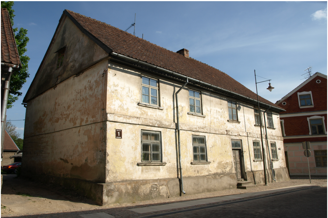
Kalna1_62010220070001_fasade2 Skats uz ēku no ziemeļiem.
