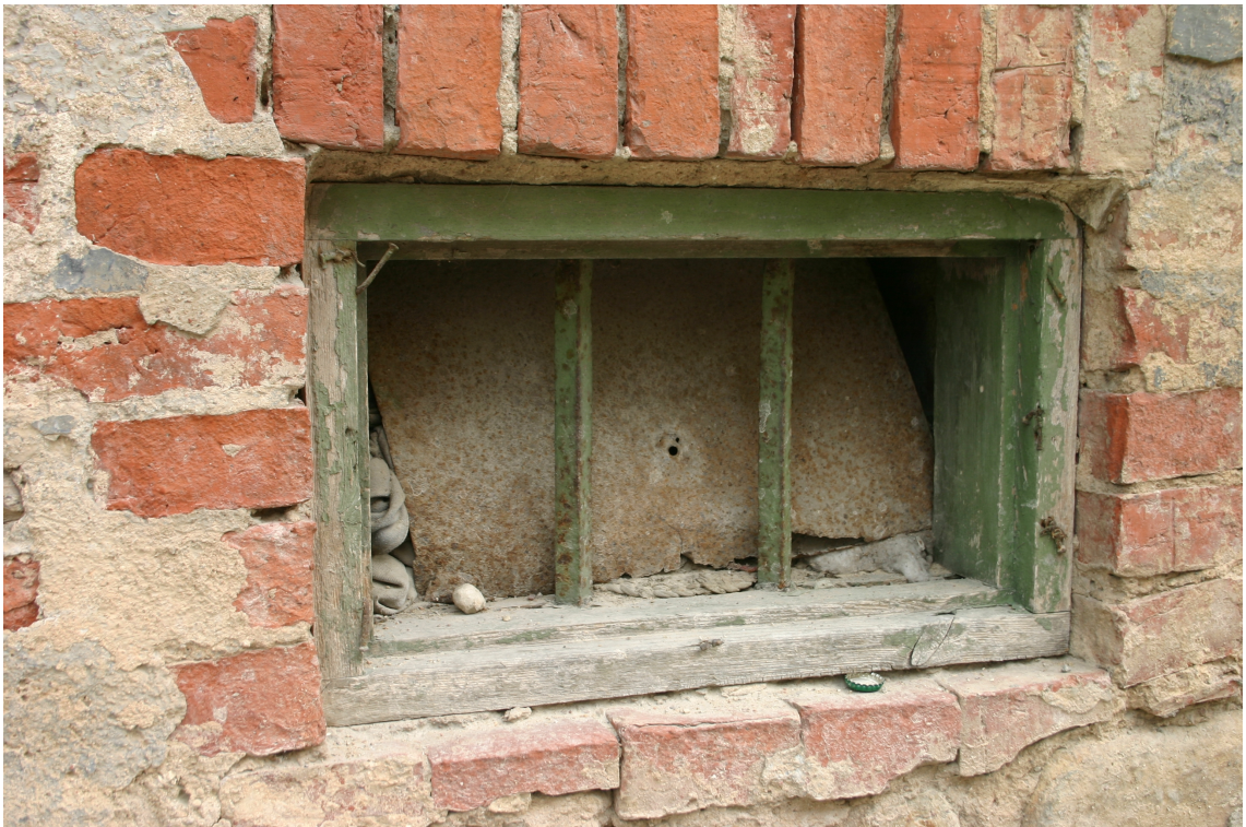
Kalna_15_62010220073001_logs4 Vēsturiska aploda un metāla restes.
