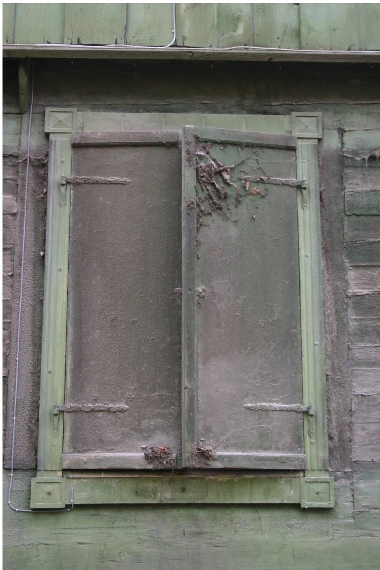
Kalna_15_62010220073001_slegi1 19.gs.1.cet. loga apmales un vēsturiski slēgi ar oriģinālo aprikojumu.
