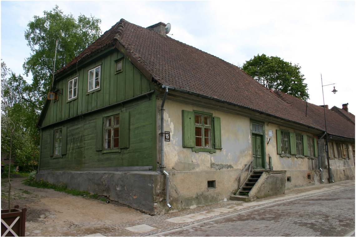
Kalna_15_62010220073001_fasade1 Skats uz ēku no ziemeļrietumiem.
