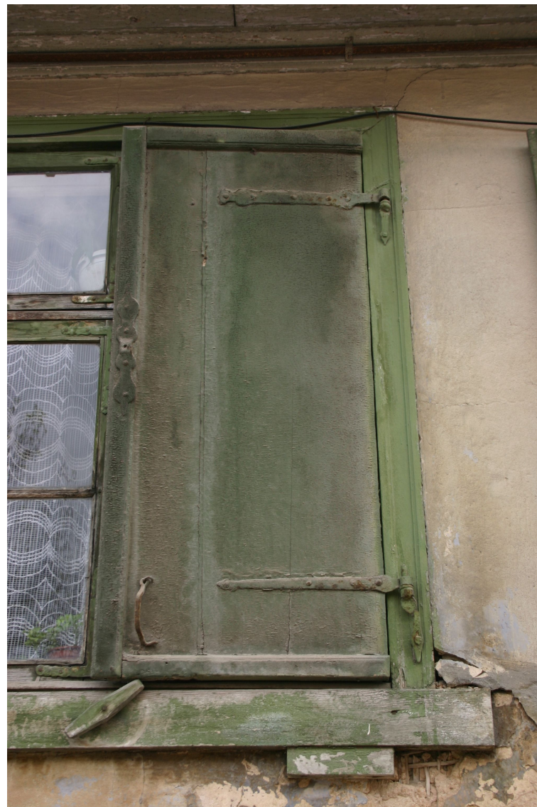
Kalna_15_62010220073001_slegi2 19.gs.1.cet. slēģis ar oriģinālo aprikojumu un vēsturiskas loga apmales.
