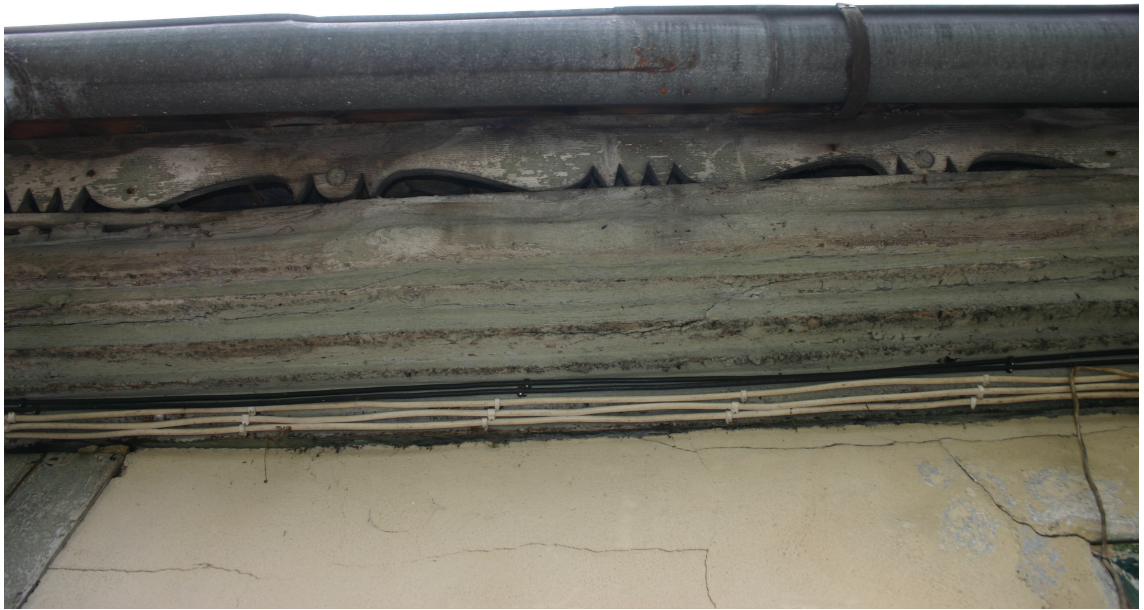
Kalna_15_62010220073001_dzega2 Sākotnēja koka dzega un vēsturisks kokā griezts aizsegdēlis.
