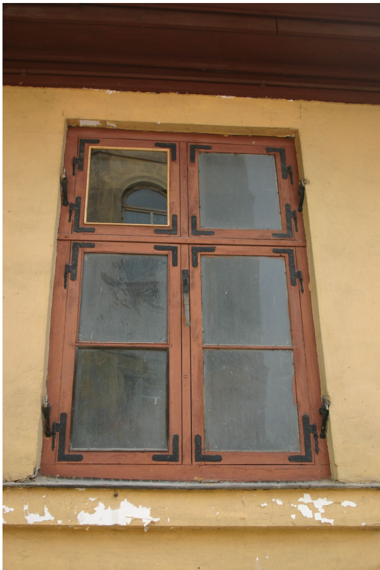
Kalna_14_62010220030001_logs1 19.gs.beigu logs ar oriģinālo aprīkojumu.
