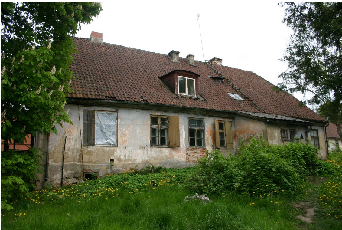
Kalna_14_62010220030001_fasade4 Ēkas rietumu fasāde.
