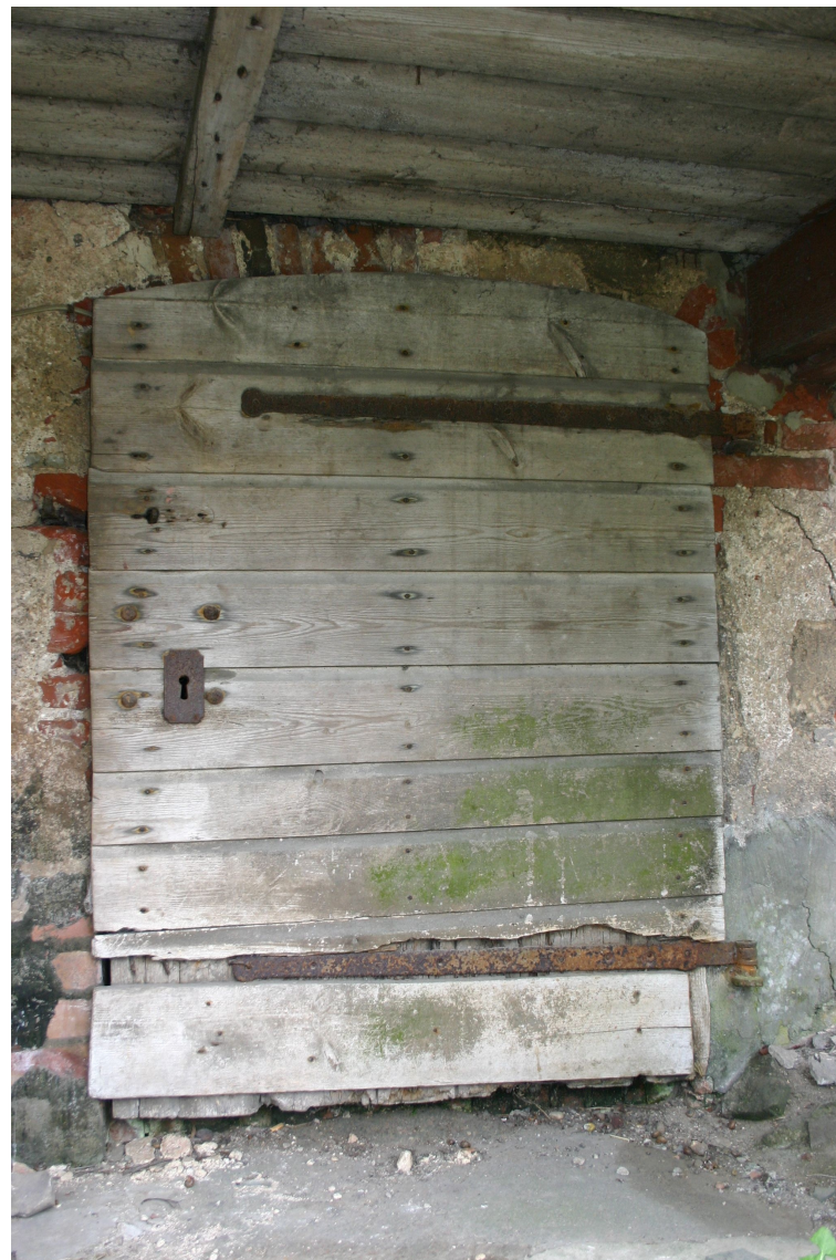
Kalna_14_62010220030001_durvis3 Vēsturiskas durvis ar oriģinālo aprikojumu.
