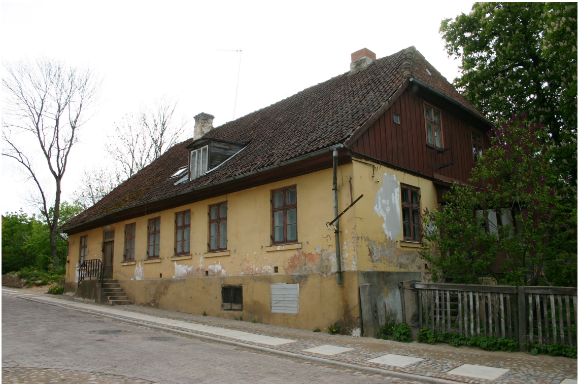
Kalna_14_62010220030001_fasade2 Skats uz ēku no ziemeļaustrumiem.
