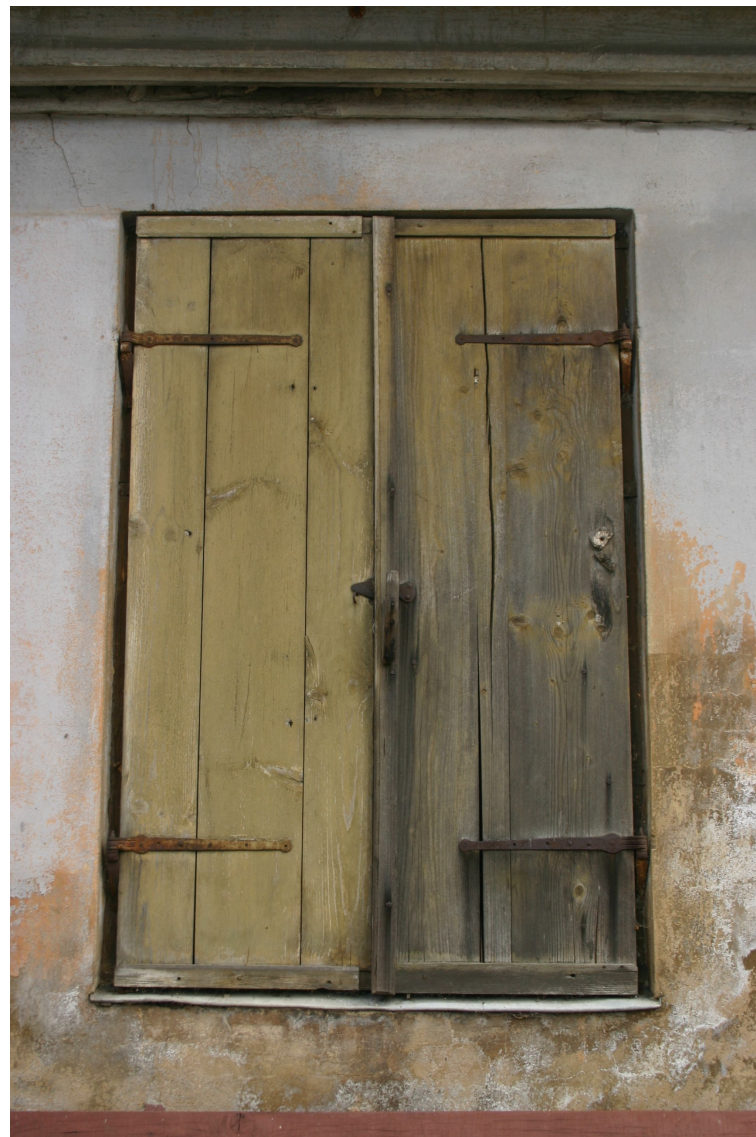
Kalna_14_62010220030001_slegi1 Vēsturisks slēģis ar oriģinālo aprīkojumu.
