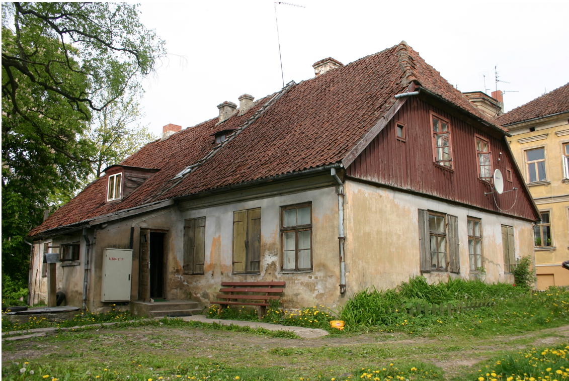
Kalna_14_62010220030001_fasade3 Skats uz ēku no dienvidrietumiem.
