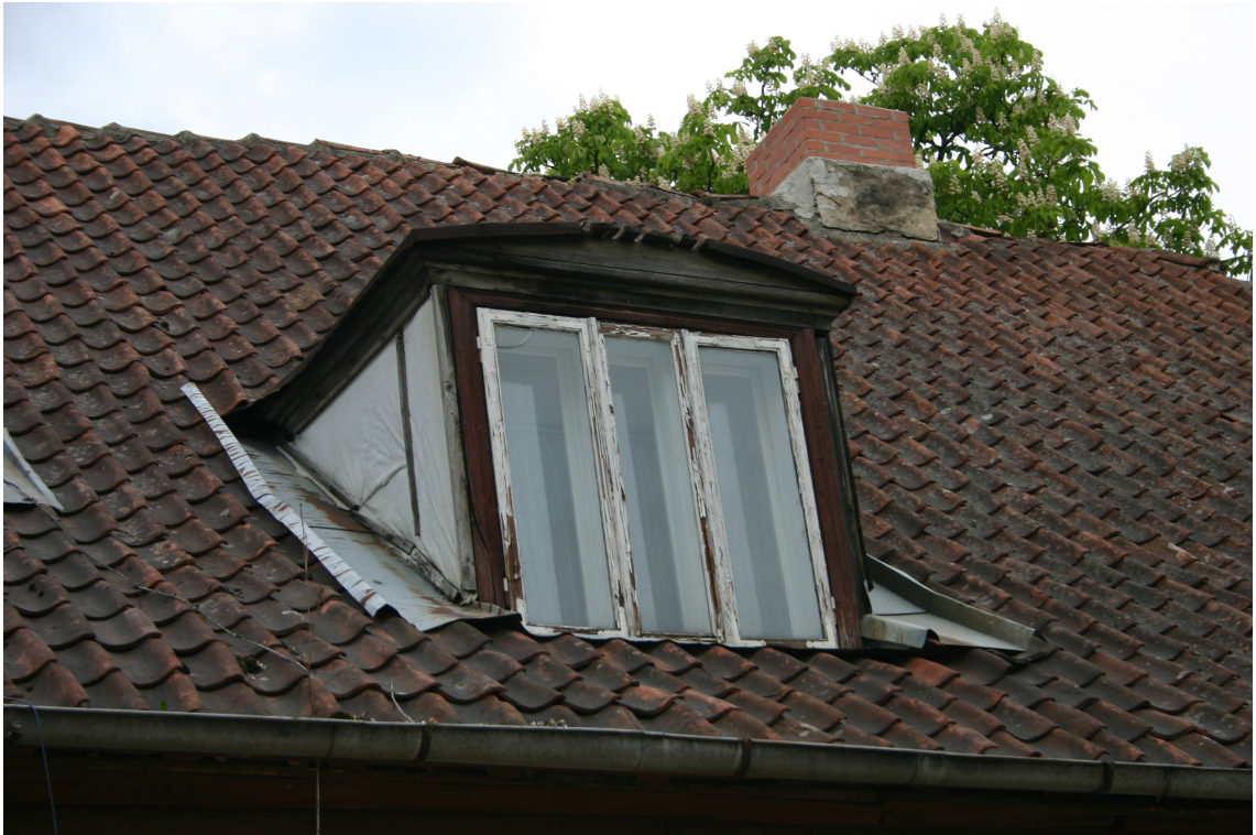
Kalna_14_62010220030001_fragments1 Vēsturiska jumta izbūve. Logs – 20.gs.2.puse, tam izmantoti 19.gs.3.cet. stūreņi.
