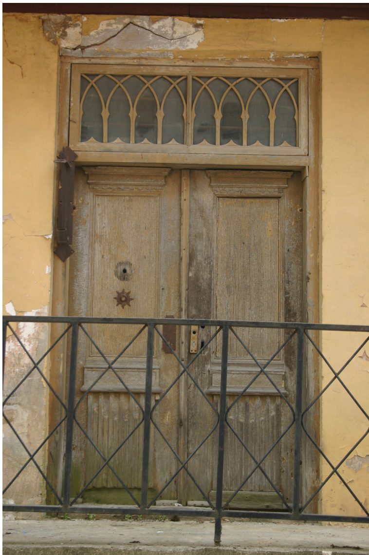
Kalna_14_62010220030001_durvis1 19.gs.vidus durvju komplekts ar daļēji saglabājušos oriģinālo aprikojumu.
