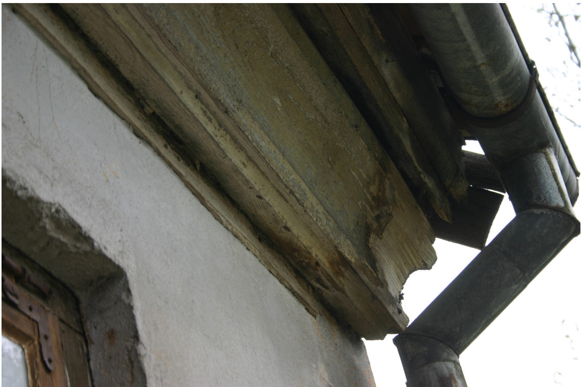
Kalna_14_62010220030001_dzega1 Dzega, domājams, izmantota no sākotnējās ēkas.
